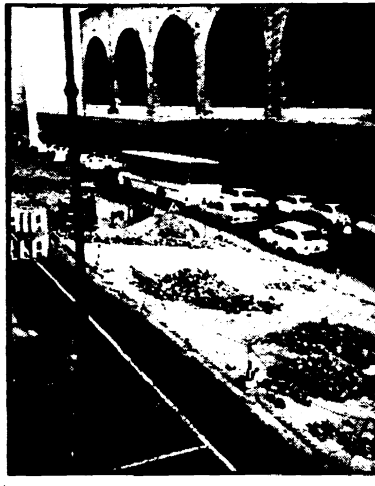
VIA MARSALA da più di un mese è pressoché bloccata. Tutta la fetta centrale della strada è stata completamente sventrata e per il passaggio delle auto rimangono soltanto due strette strisce, due anguste corsie alti ai lati, una accanto al marciapiede della stazione, l'altra a fianco dei palazzi. Nelle ore di punta così, in una strada solitamente trafficante di traffico, in lunghe file le vetture transitano a passo d'uomo, quando addirittura non sono costrette ad attendere immobili per ore, prima di avere libero accesso. Per compiere poche centinaia di metri insomma si impiega una eternità.
