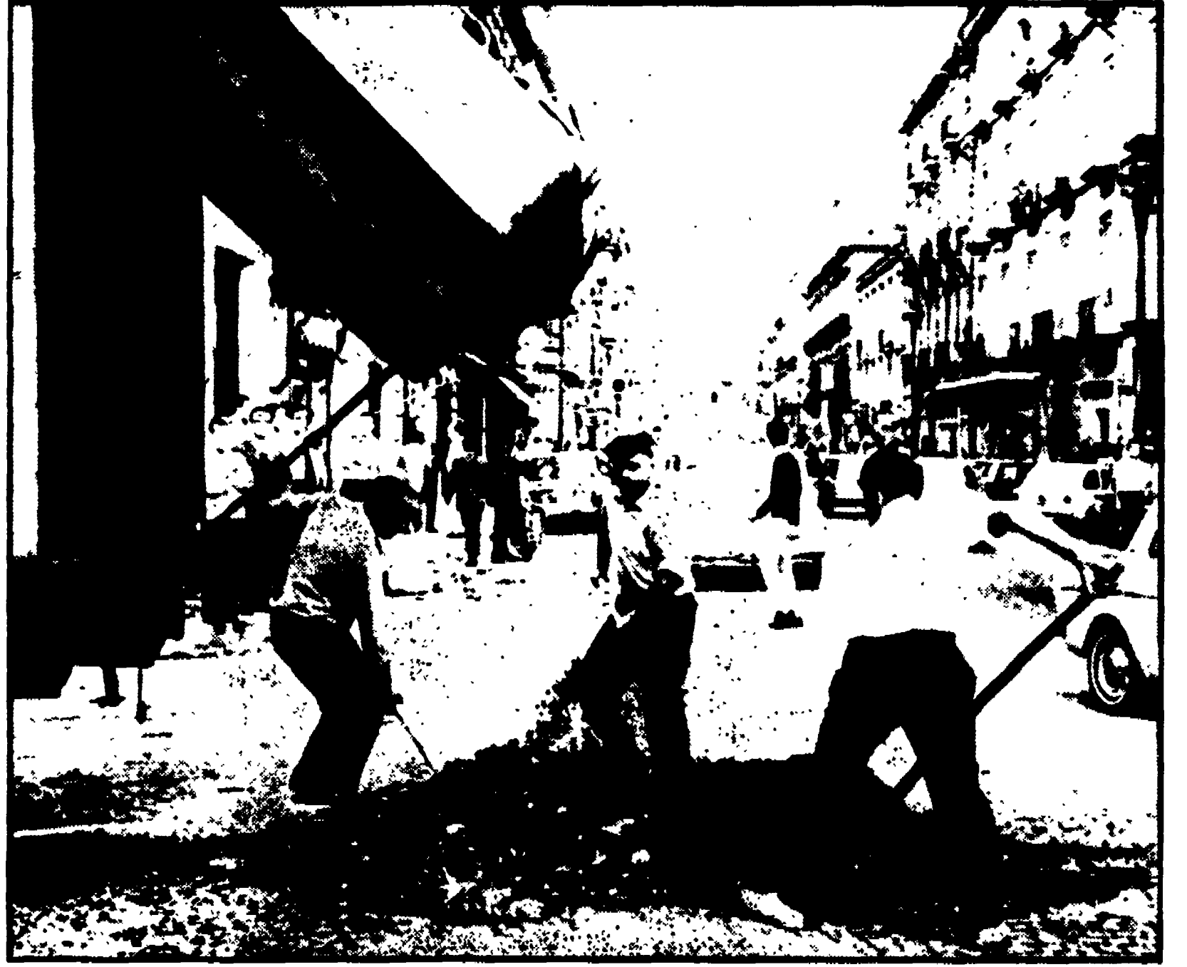
In una strada di Caserta, dopo gli scontri dei giorni scorsi, alcuni operai rimuovono mucchi di detriti
