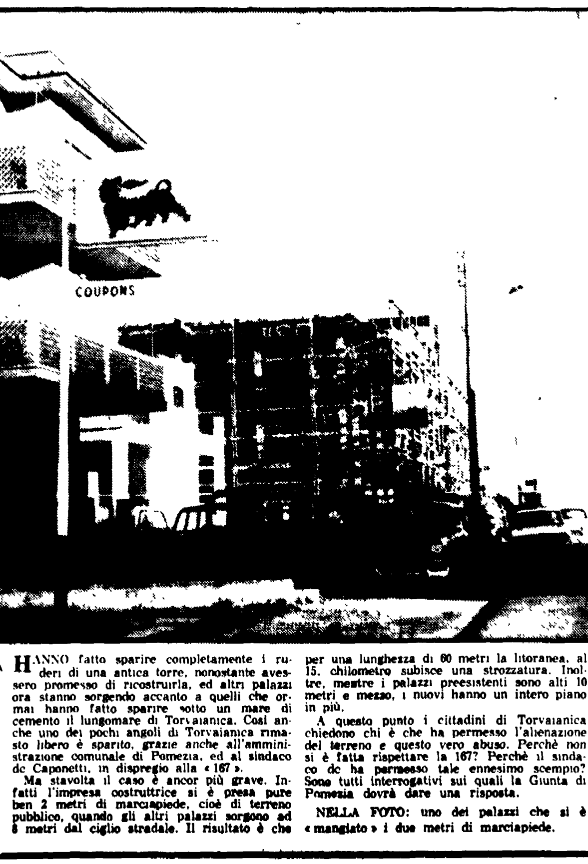
HANNO fatto sparire completamente i ruderi di una antica torre, nonostante avessero promesso di ricostruirla, ed altri palazzi ora stanno sorgendo accanto a quelli che ormai hanno fatto sparire sotto un mare di cemento il lungomare di Torvajonica. Così anche uno dei pochi angoli di Torvajonica rimasto libero è sparito, grazie anche all'amministrazione comunale di Pomezia, ed al sindaco Capanetti, in disprezzo alla legge. Ma stavolta il caso è ancor più grave. Infatti l'impresa costruttrice si è presa pure ben 2 metri di marciapiede, cioè di terreno pubblico, quando gli altri palazzi sorgono ed è metri dal ciglio stradale. Il risultato è che
