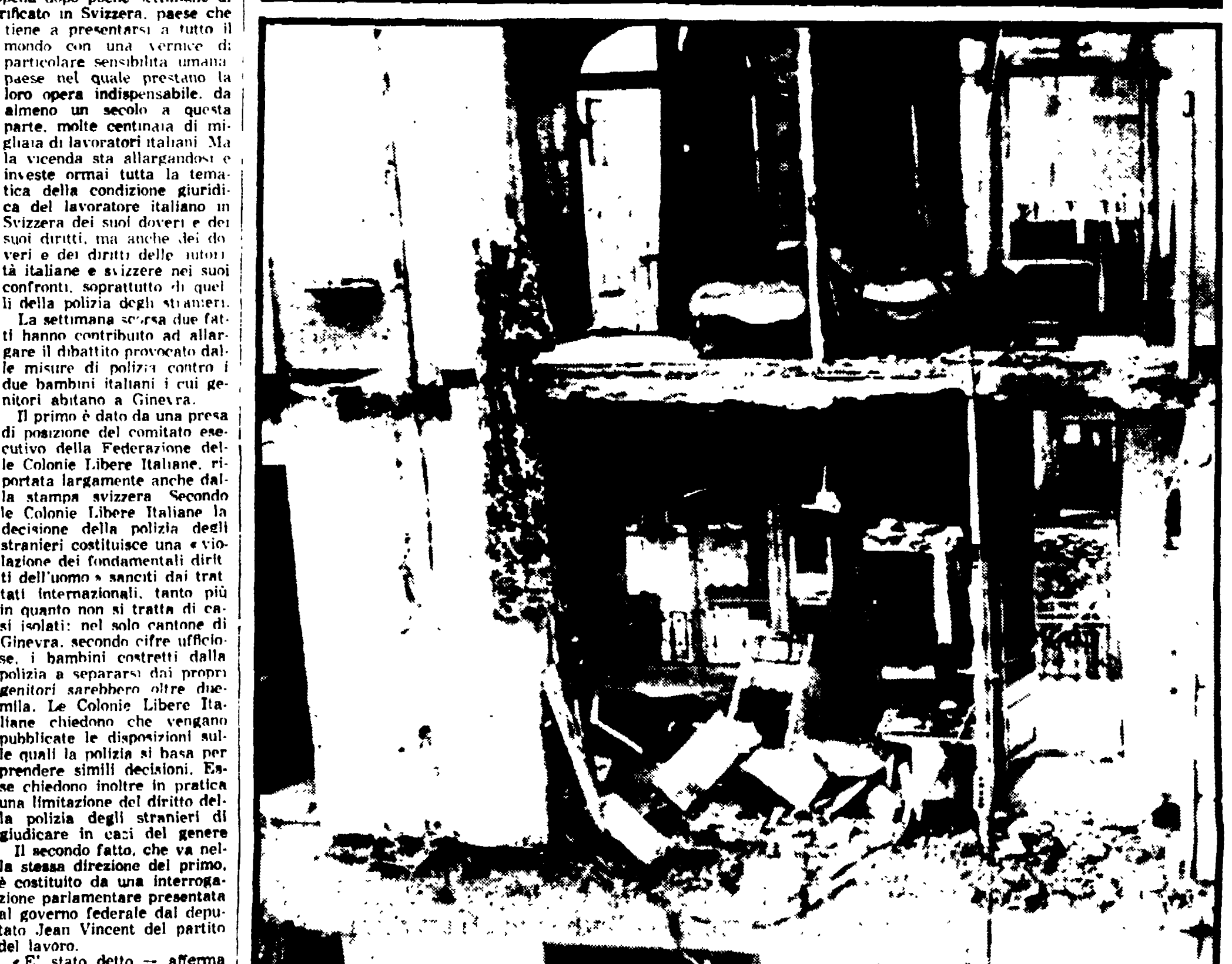
BARCELONA, 3. Una casa di quattro piani è crollata stamani, travolgendo numerose persone: 7 morti, 3 dispersi e 6 feriti gravi costituiscono il primo tragico bilancio. Il crollo è stato provocato da lavori di sterro in corso in prossimità dell'edificio, per la costruzione di un parcheggio sotterraneo. Finora i vigili del fuoco hanno estratto dalle macerie il cadavere di un uomo e altre cinque persone gravemente ferite. Il sinistro è avvenuto alle 8,15 del mattino, preceduto da un sinistro, tremendo boato. Anche alcuni operai che stavano lavorando alla costruzione del parcheggio sono rimasti intrappolati fra le macerie. Le squadre di soccorso continuano le ricerche, lavorando affannosamente per estrarre le vittime. Nella foto: il palazzo dopo il tragico crollo.
