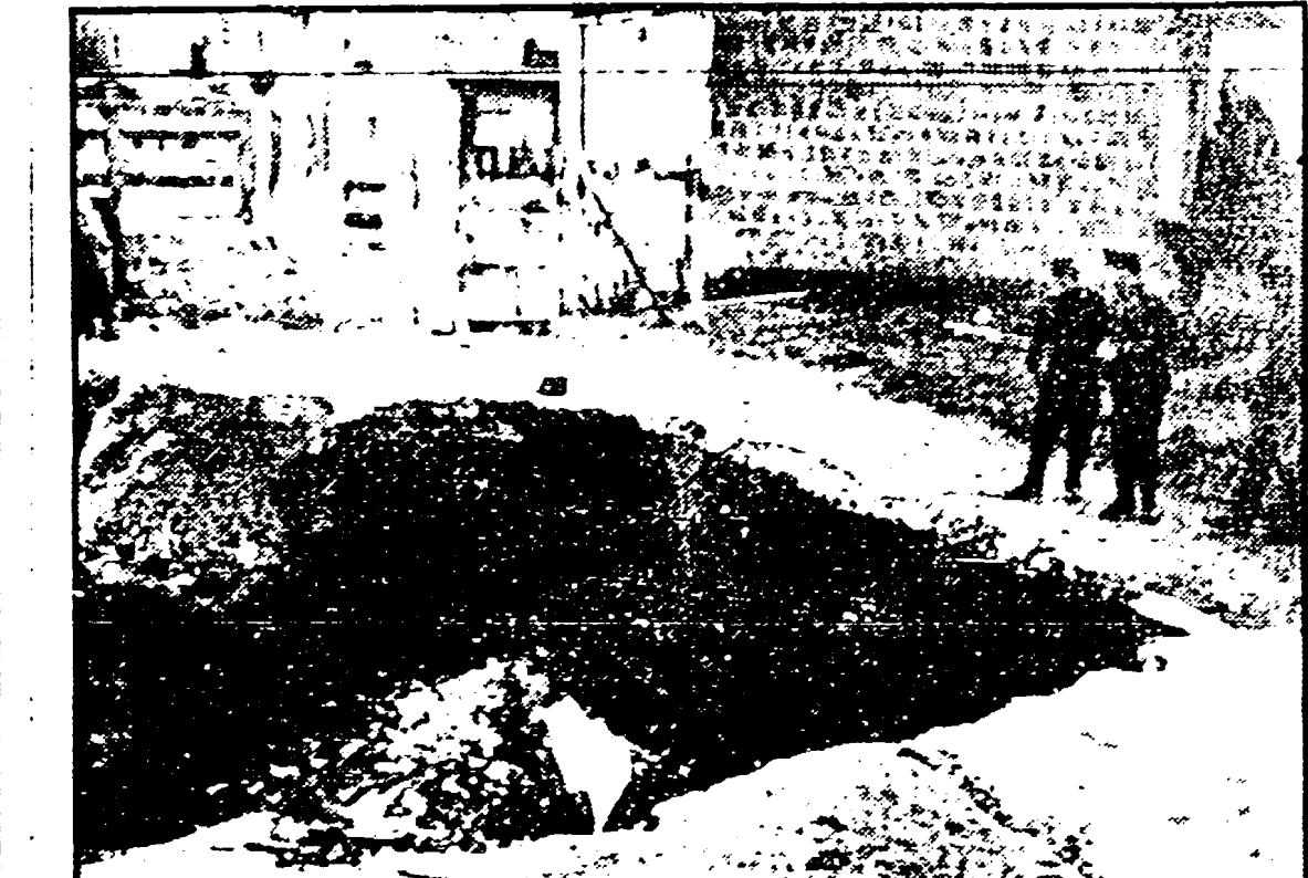
Prosegue l'incubo per gli abitanti di Cardito, il paese vicino Napoli dove la pioggia — facendo traboccare una vasca di raccolta delle acque — ha fatto crollare una trentina di case. Decine di voragini si sono aperte. La popolazione fugge in massa anche dalle abitazioni rimaste i piedi e i senza letto ammontano a oltre 900. Nella foto: una delle voragini aperte in una strada di Cardito.
