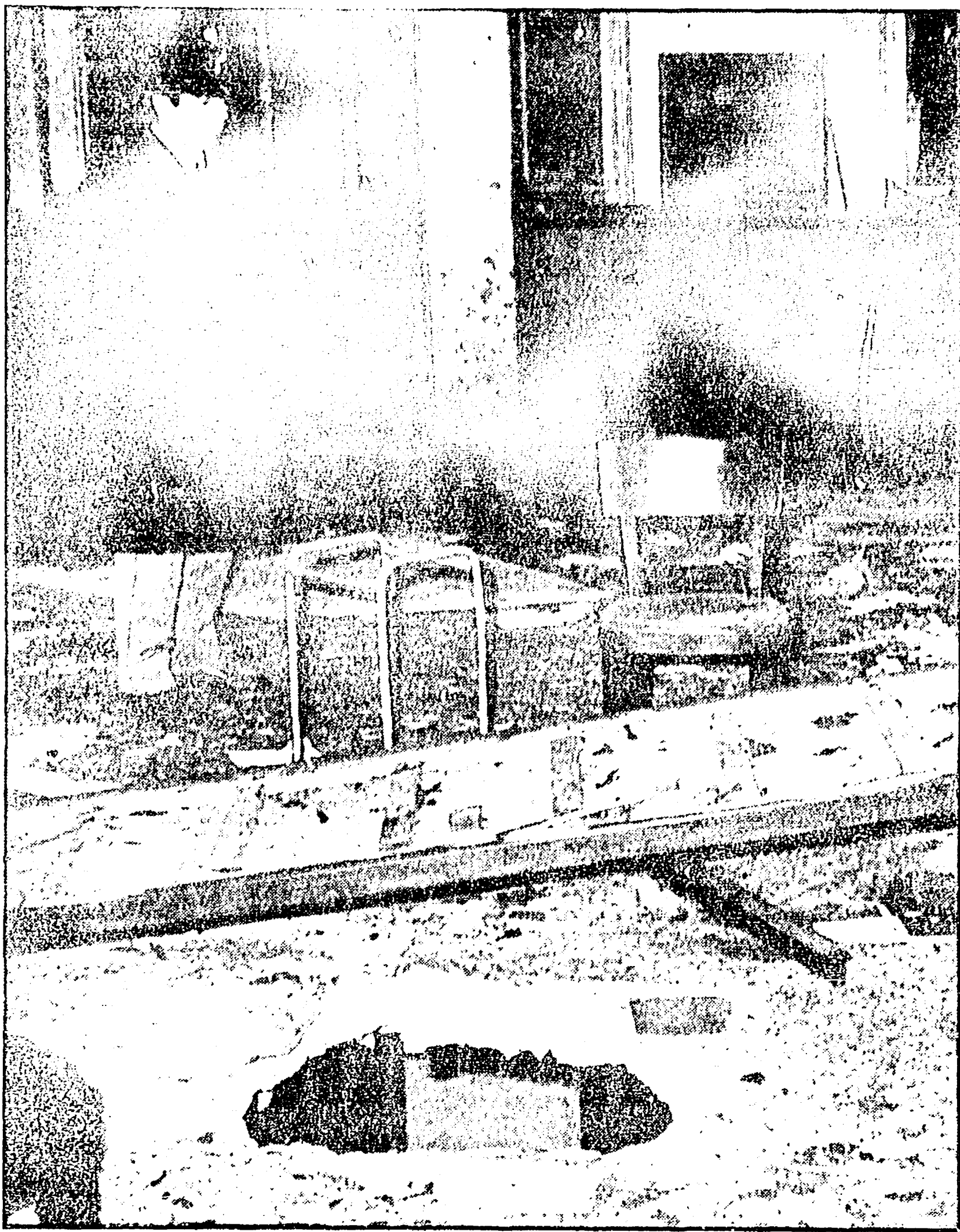
Così si presentava, ieri, il salone centrale della Banca Nazionale dell'Agricoltura di Milano. Dove c'è il foro gli assassini avevano collocato il loro ordigno esplosivo. Le dimensioni dello squarcio possono dare una idea della violenza dell'esplosione
