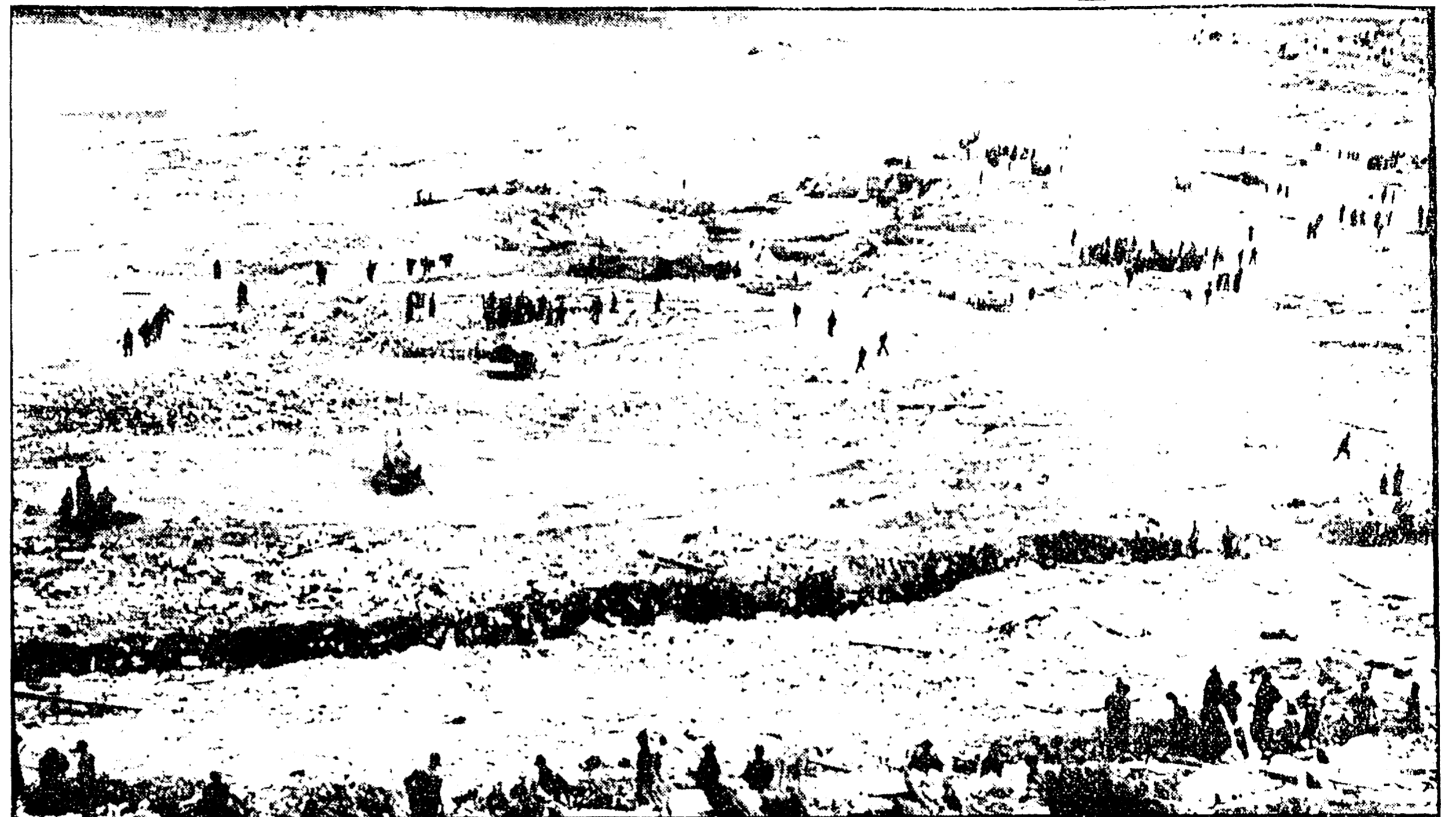
10 Ottobre 1963 il monte Toc frana e provoca una spaventosa ondata che, superato il ciglio della diga, piomba a valle spazzando via tutto. Longarone non esiste più, i morti sono 2009. La luce del sole scopre il giorno successivo un deserto senza vita. Nella foto accanto, gli imputati. Da sinistra in alto Frosini, Batini, Sensidoni, Marin, Ghetti, Tonini, Biadene, Violin
