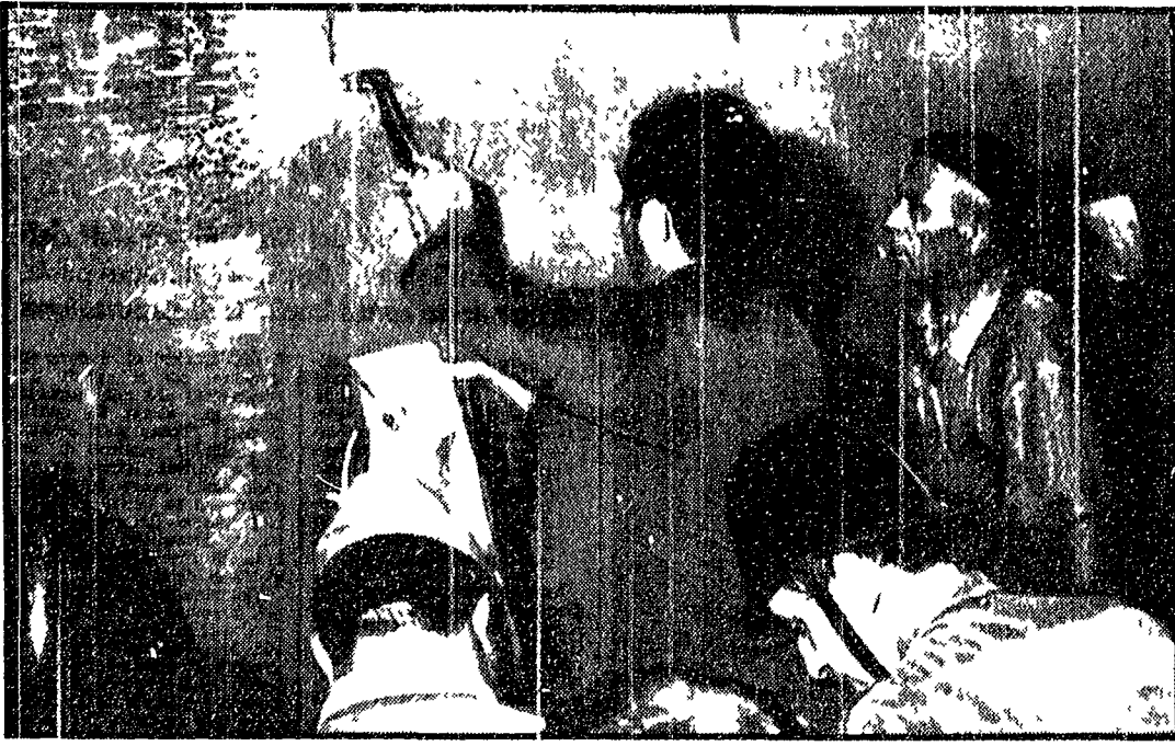
GIOIA TAURO — Vigil del fuoco al lavoro con la fiamma ossidrica su una delle vetture deragliate
