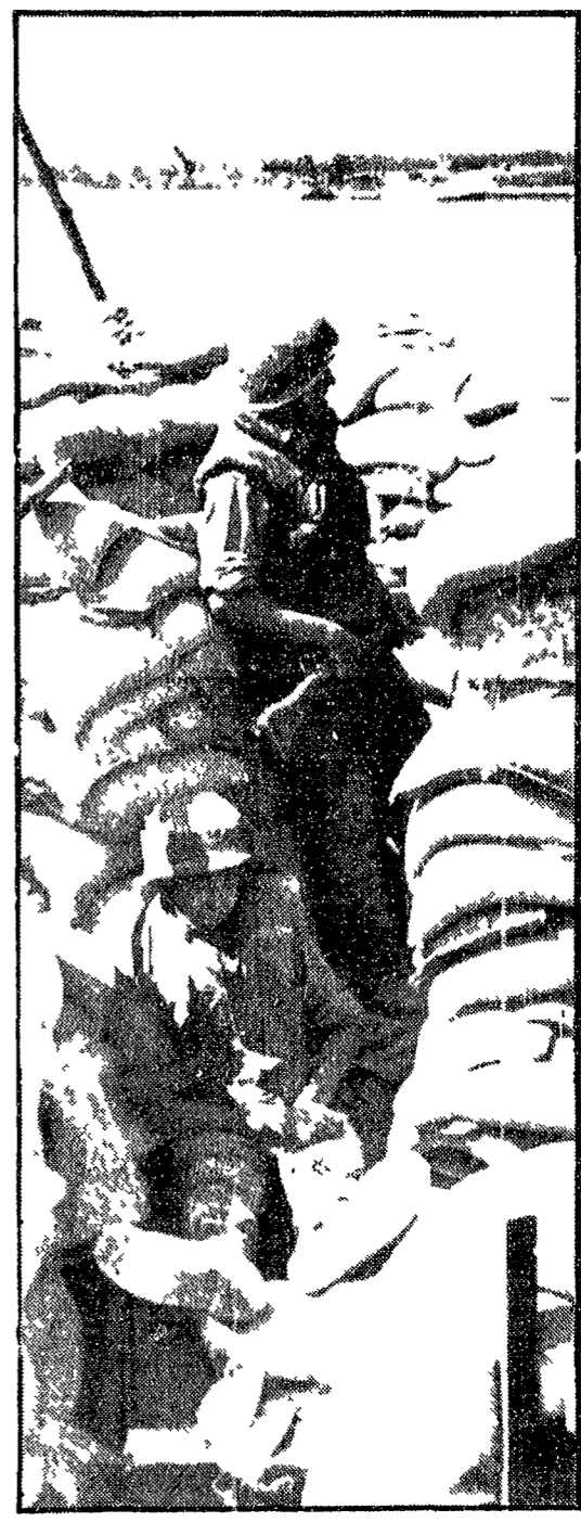
CANALE DI SUEZ. Trincea israeliana dopo il cessate il fuoco
