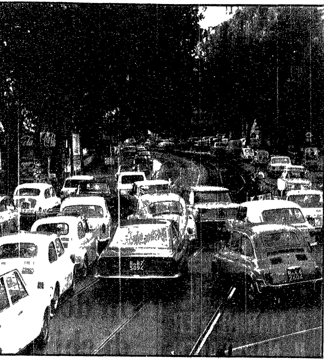
Traffico impazzito sui lungotevere, specie nel tratto fra l'anagrafe e ponte Garibaldi, a causa dei lavori alla sede stradale con sostituzione dei binari. E' così ogni anno. All'inizio dell'autunno, quando il traffico automobilistico comincia a farsi intenso, le strade di Maggiore traffico vengono regolarmente all'aria. Non potrebbero in Comune, una volta per tutte, programmare ed eseguire durante l'estate, quando la città è vuota, i pur necessari lavori stradali?
