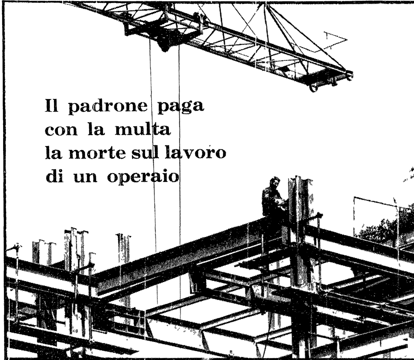
Corso d'Italia, a Roma costruzione di un albergo con i metodi più moderni, tutto in ferro. Ma l'operaio lavora a venti metri di altezza, a cavalcioni di una trave, senza alcuna protezione.
