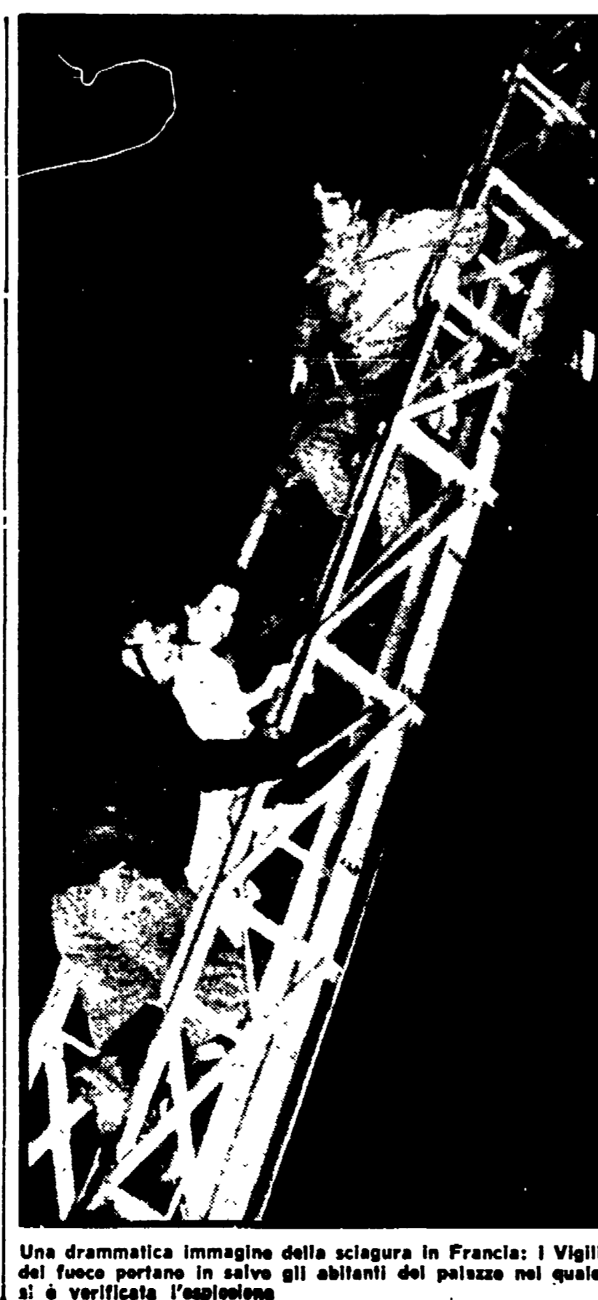
Una drammatica immagine della sciagura in Francia: i Vigili del fuoco portano in salvo gli abitanti del palazzo nel quale si è verificata l'esplosione
