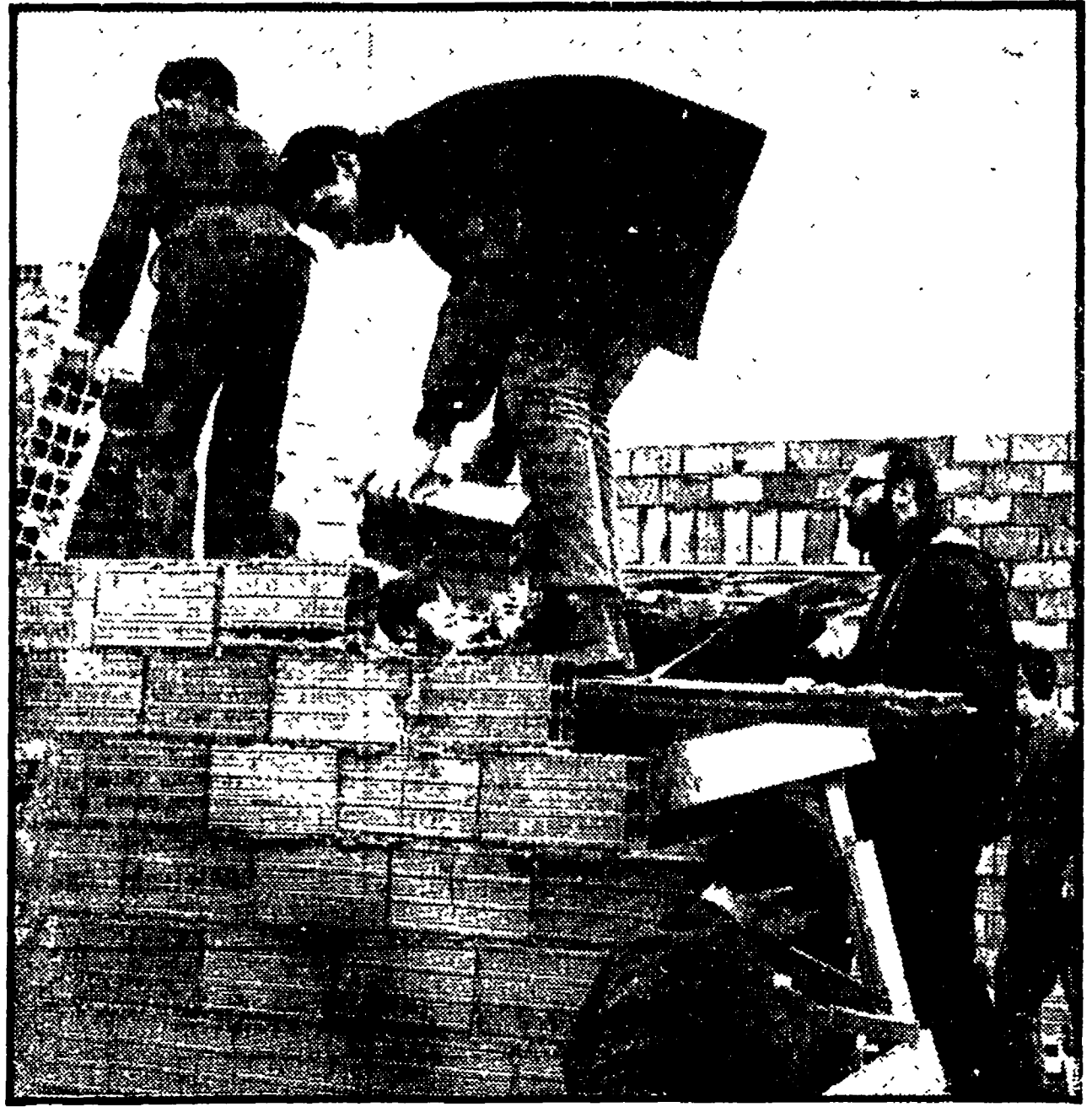
L'officina dei ragazzi dell'Acquedotto Felice, una baracca che si erano costruiti da soli con l'aiuto del loro sacerdote-maestro Roberto Sardelli, è stata abbattuta ieri mattina; sono stati loro stessi, i ragazzi, a buttar giù a colpi di piccone i mattoni che avevano messo insieme tre mesi fa. L'officina era «abusiva», così come abusive sono tutte le centinaia di baracche della zona...
