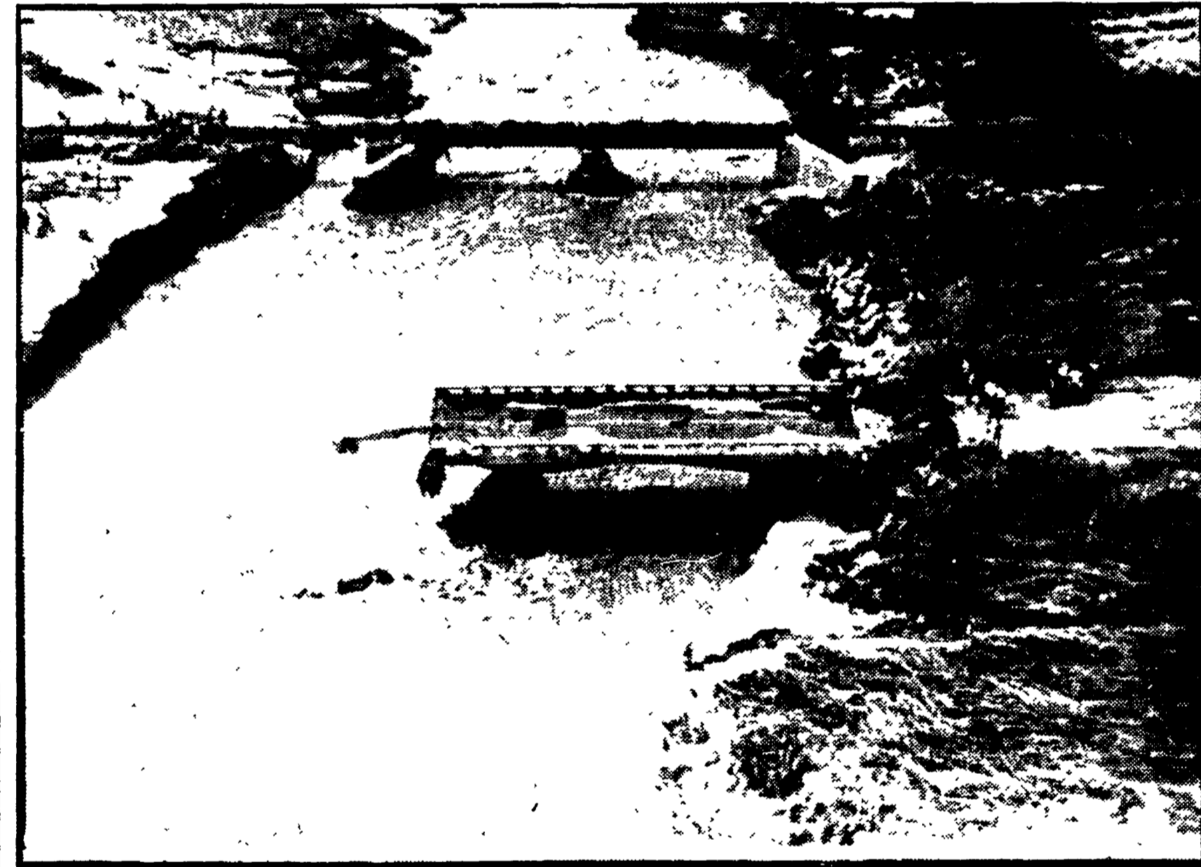
RIO DE JANEIRO - Il ponte che univa Rio Bonito alla capitale del Brasile è crollato, ieri, proprio mentre vi stavano passando sopra alcune auto...
