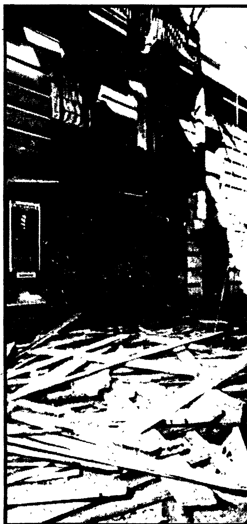
Si sgombra la strada dopo il crollo
