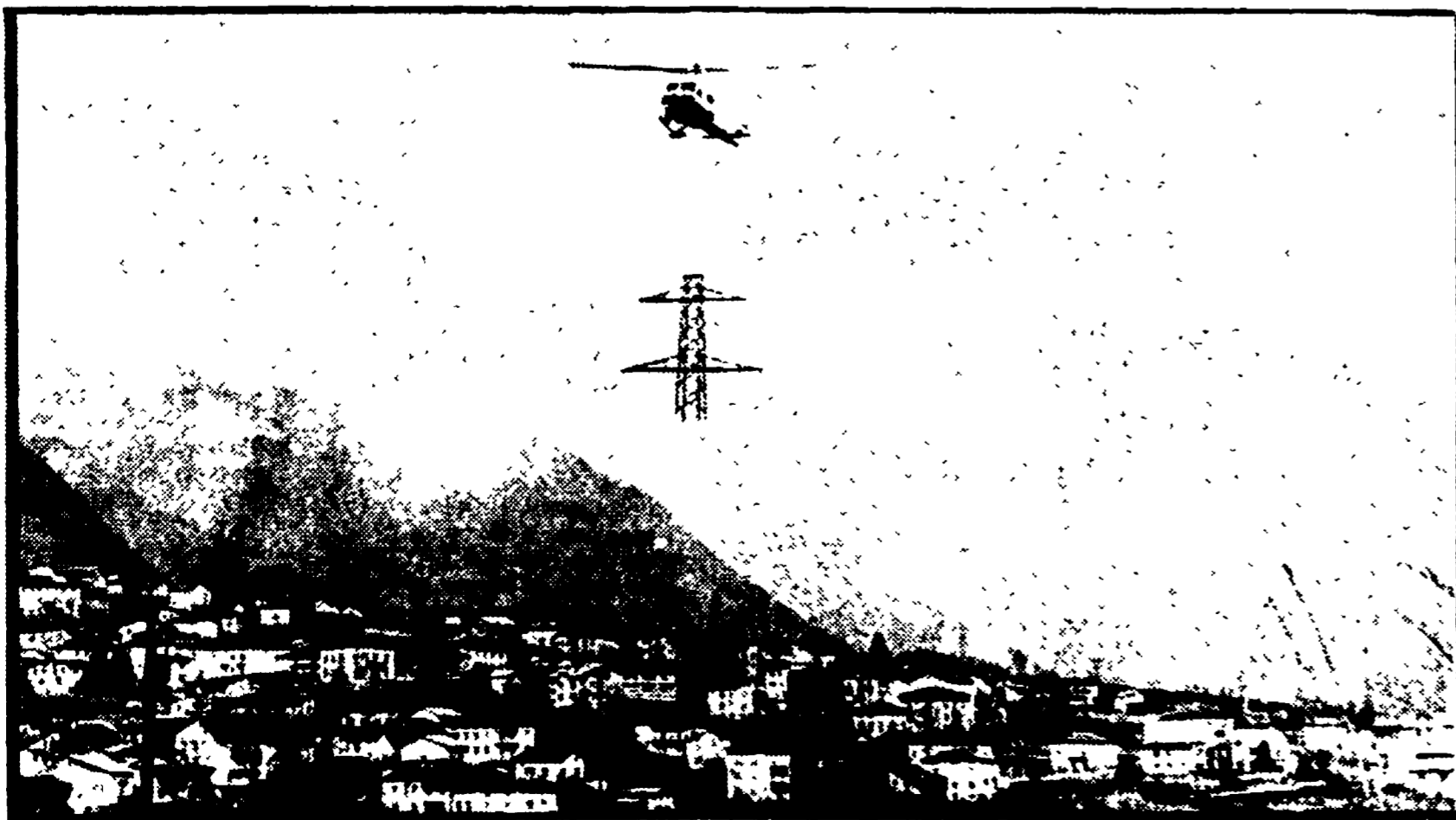
L'elicottero va assumendo, in ogni settore industriale, una sempre più grande importanza. L'ENEL ha provveduto, dal canto suo, alla sperimentazione del mezzo aereo in svariati lavori di elettrificazione. I risultati maggiormente significativi sono rappresentati dalla notevole economicità del lavoro riferita soprattutto ai tempi di montaggio di tralicci e pali per linee elettriche.
