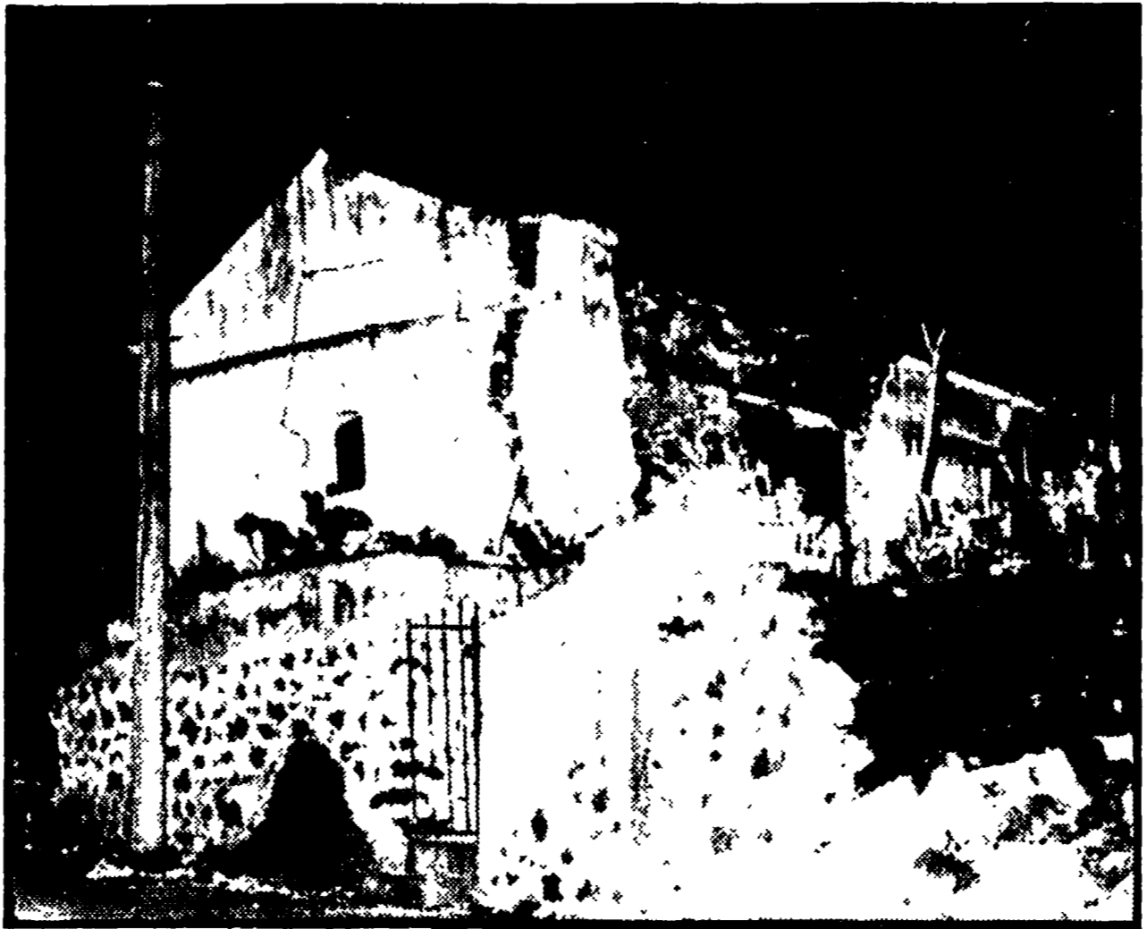
CATANIA, 21. Una scossa di terremoto, che ha avuto come epicentro i paesi della fascia orientale dell'Etna, ha provocato il crollo di alcune abitazioni e il ferimento di sette persone, che sono state medicate all'ospedale di Giarre e giudicate quarant'ore in pochi giorni. Il sisma è stato avvertito alle 17,30 a Catania e nei paesi della zona orientale dell'Etna. Il movimento tellurico, che ha avuto carattere ondulatorio, è stato valutato dagli apparecchi dell'Istituto geofisico e geodetico dell'università di Messina tra il quarto e il quinto grado della scala Mercalli. Le abitazioni sono crollate a Croce ed a Macchia di Giarre, della Regione, nei pressi della chiesa Madre. I feriti sono, per buona parte, operai di una cava di pietra che è franata a causa del terremoto, la cui origine potrebbe essere messa in relazione all'intensa attività dell'Etna. I feriti sono: Alfio Catalano, di 34 anni, suo figlio Sebastiano, di otto; Rosario Arena, di 61 anni, sua moglie Vito, di 30 ed il loro figlio Mario, di 4; Palma Nicolosi, di 60 anni e Orazio Lo Castro, di otto. Tutti hanno riportato ferite non gravi, ma sono in grave stato di choc. Da Catania sono partite numerose squadre di vigili del fuoco dirette a Giarre ed alle frazioni di Macchia e Sciera di San Giovanni. Anche i carabinieri hanno inviato militari di rinforzo alle stazioni di vari paesi della fascia ionica del vulcano. NELLA FOTO: una casa crollata a Giarre.
