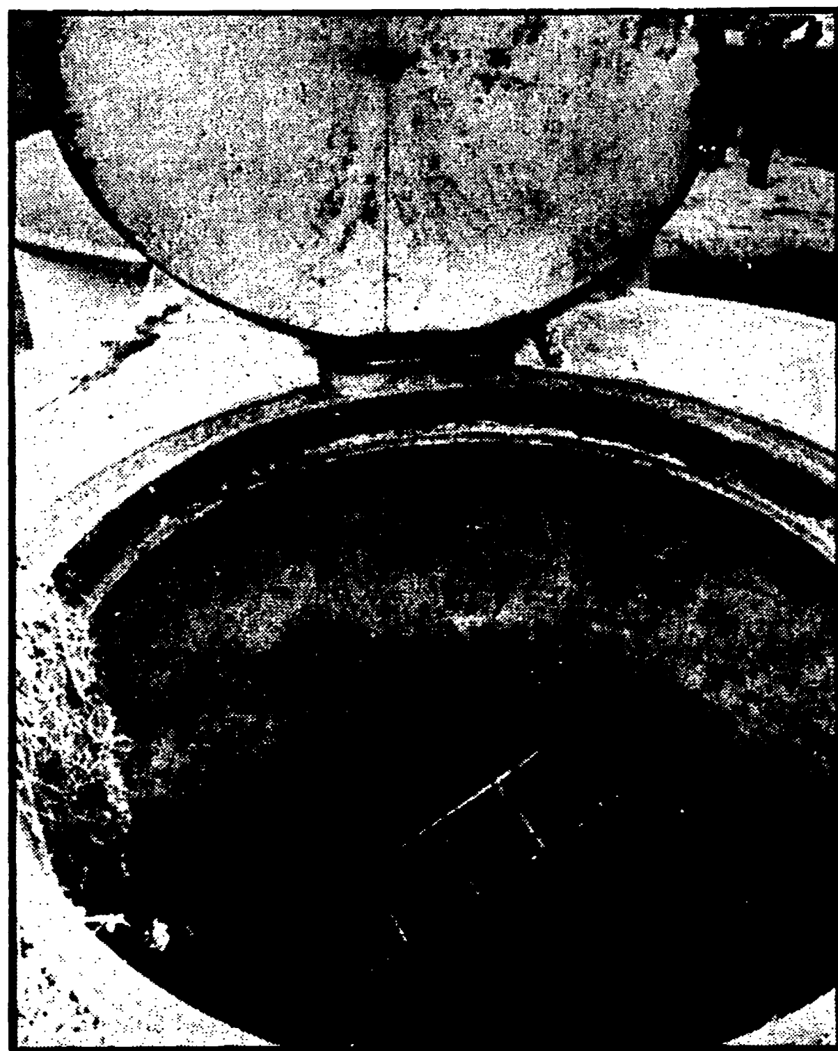
L'interno del silos, adibito a deposito di fieno, dal quale sono stati estratti i tre operai, due dei quali non sono sopravvissuti alle esalazioni.
