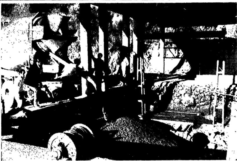
CATANIA - Si ricopre con uno spesso strato di calcareuzzo e di fogli di amianto una delle sorgenti che alimentano i pozzi della zona, nel tentativo di salvare il rifornimento idrico della lava.
