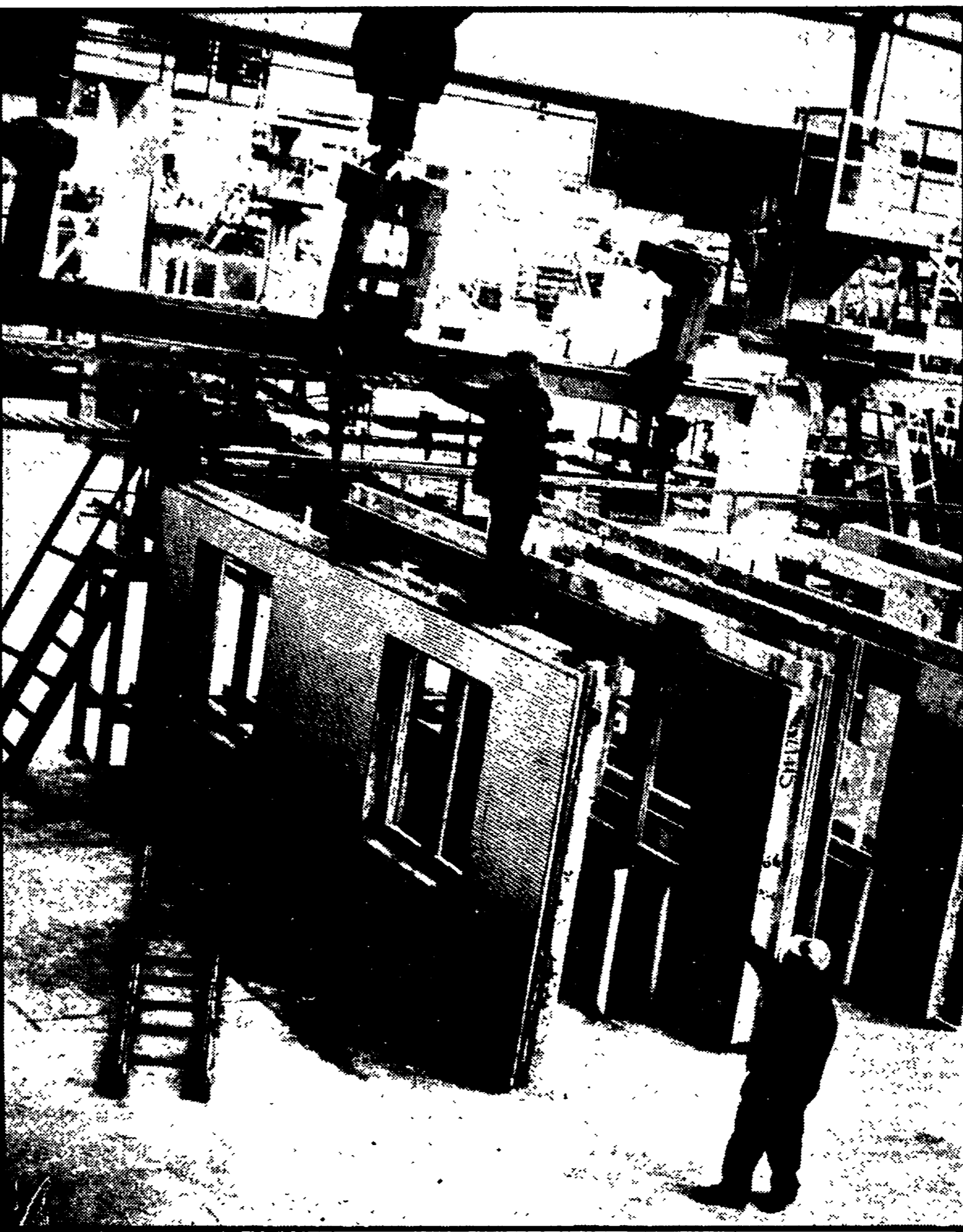
Un reparto della fabbrica di Riga, in Lettonia, che produce gli elementi per le case d'abitazione prefabbricate.
