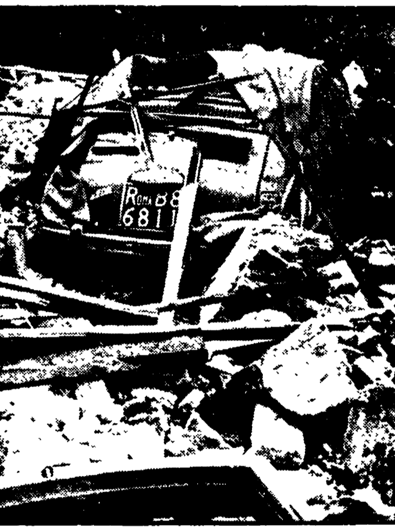
Tre immagini del crollo a piazzale Prenestino: si notano le macchine semiseppolte dalle macerie
