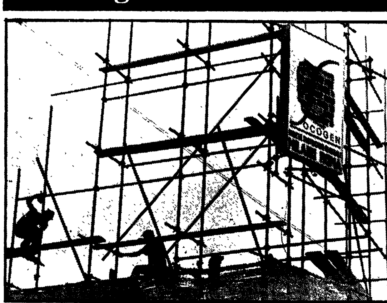
Una immagine del cantiere nell'ex convento dei cappuccini
