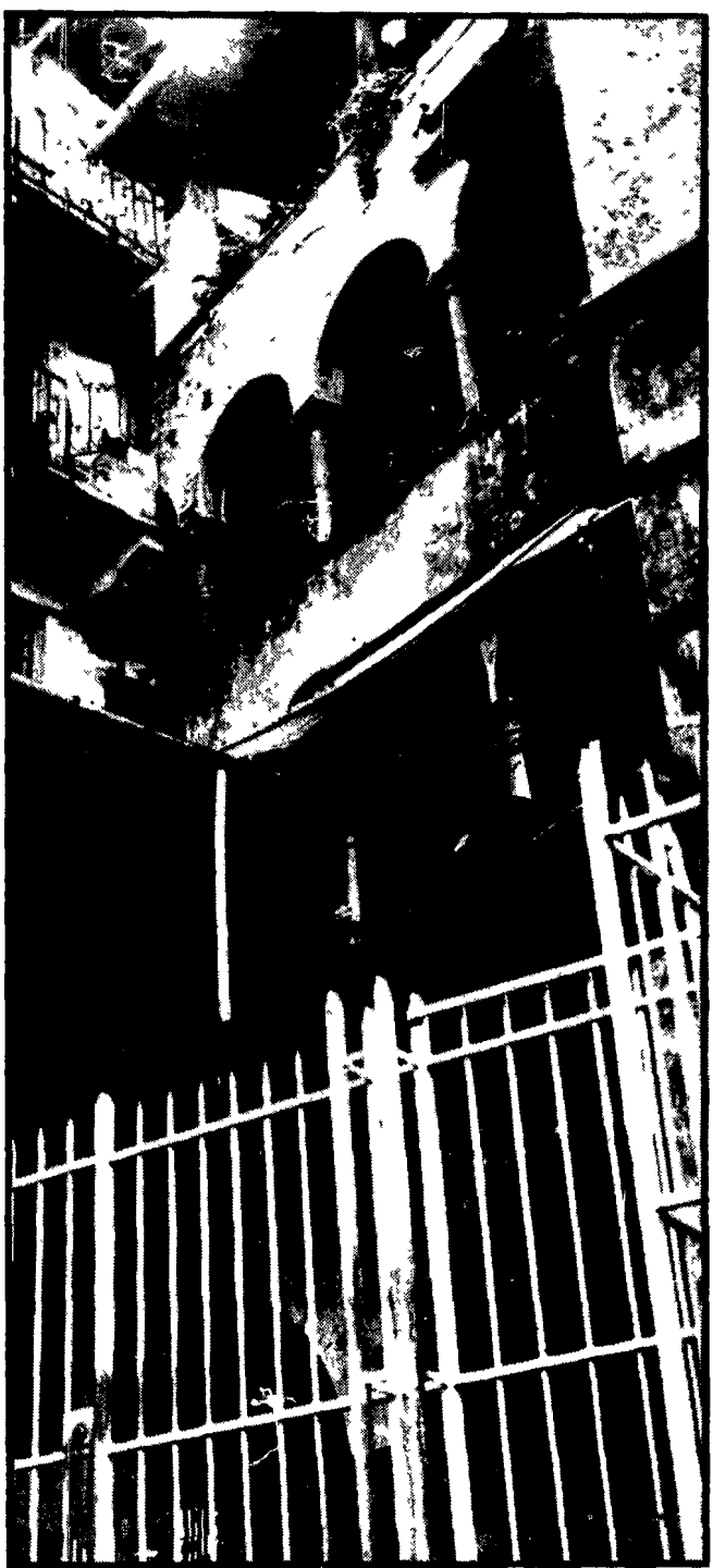
BERGAMO - Una vecchia casa della città alta. Dietro le eleganti colonnine gli interni vanno in sfacelo
