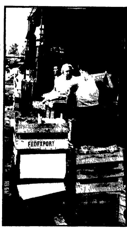
Una veduta esterna dei mercati generali: il complesso, come denuncia la Cooperativa S. Paolo, è in stato di abbandono. Il comune non vuole risolvere la crisi ormai ventennale dei Mercati generali che vanno così verso la distruzione.
