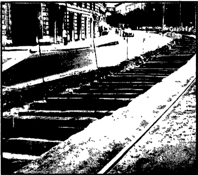
Con le prime avvisaglie del grande rientro cominciato i guai in via Labicana. Qualche giorno fa, infatti, gli operai hanno cominciato a togliere i binari, bloccando, per poche ore, i lavori una metà della carreggiata...
