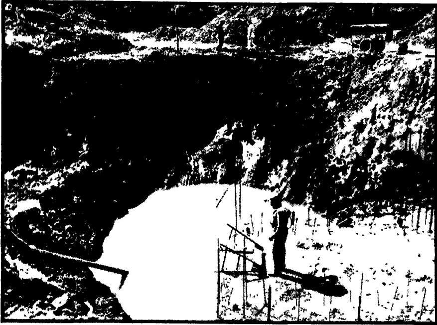
Operai al lavoro nell'ultimo tratto del Peschiera secondo
