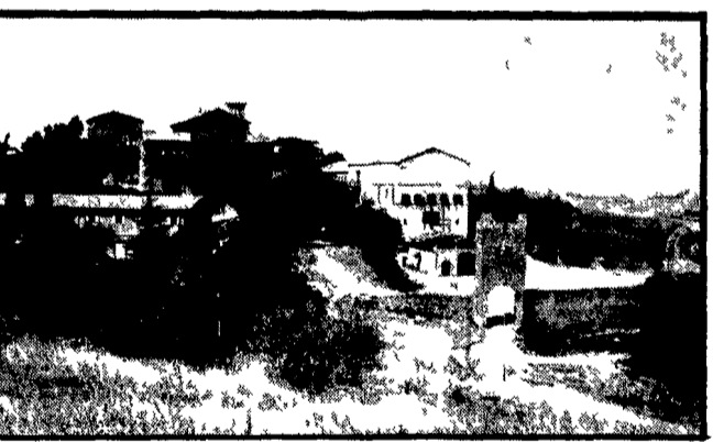
La porta centrale del Borgo medioevale di Castel di Leva, unico elemento di rilievo che rimane delle antiche mura. Sullo sfondo le costruzioni del Santuario e degli annessi stabili
