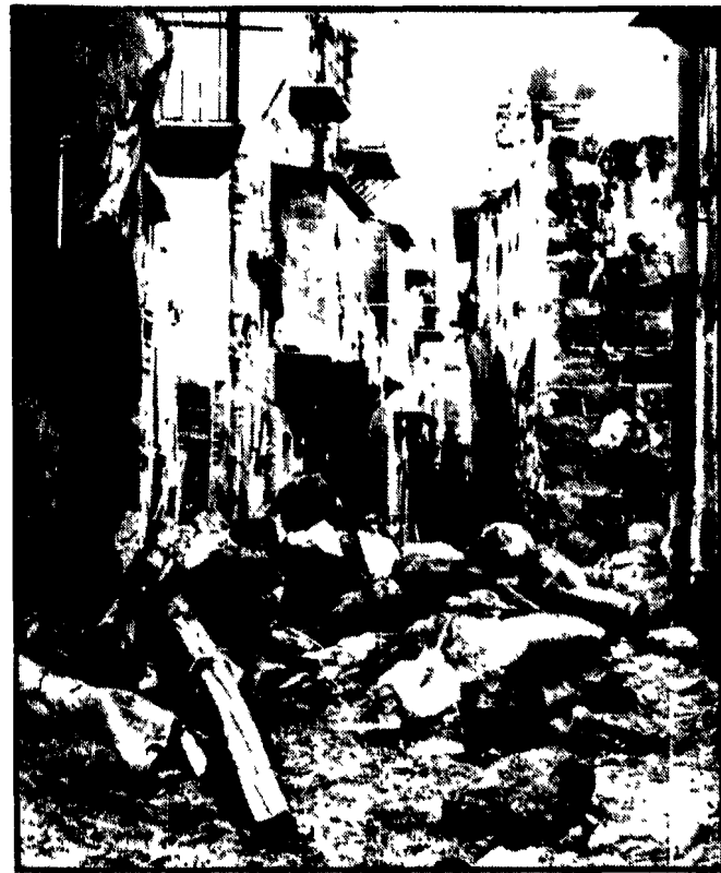
PORTO EMPEDOCLE - Una strada della zona bassa della città ancora invasa dal detriti e dalla macerie del nubifragio
