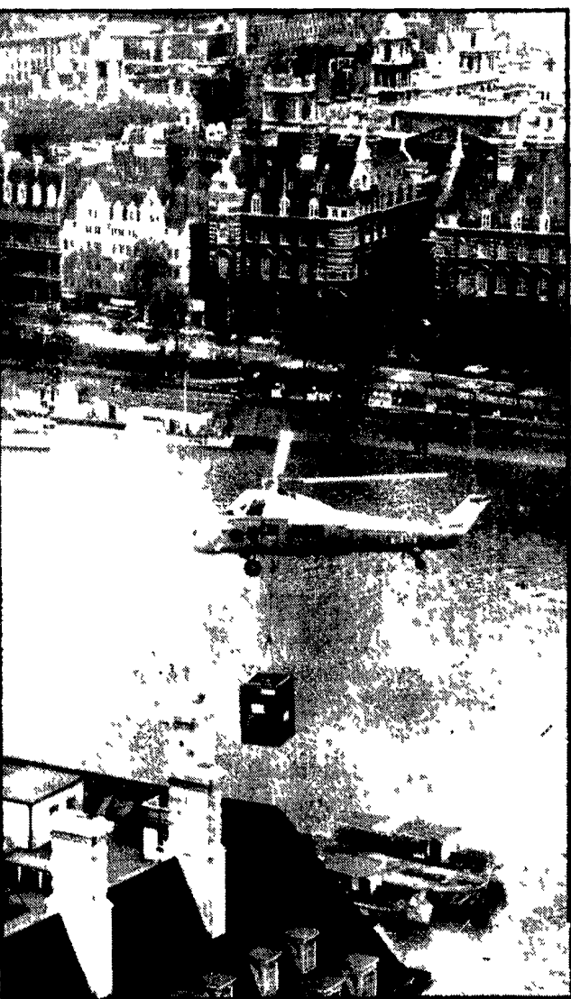
L'elicottero ha semplificato i lavori, sorvolando il traffico intenso di Londra e poi il Tamigi, per portare a destinazione il suo prezioso carico. L'oggetto misterioso che trasporta è una delle due "torri" destinate a rendere sempre costante umidità e temperatura nel municipio della capitale inglese. Un computer coordinerà l'attività delle "torri", garantendo l'aria condizionata nell'edificio.
