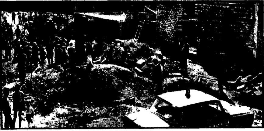
La casetta che Lorenzo Volturro stava costruendo per il fratello: una lastra di cemento gli è crollata addosso uccidendolo
