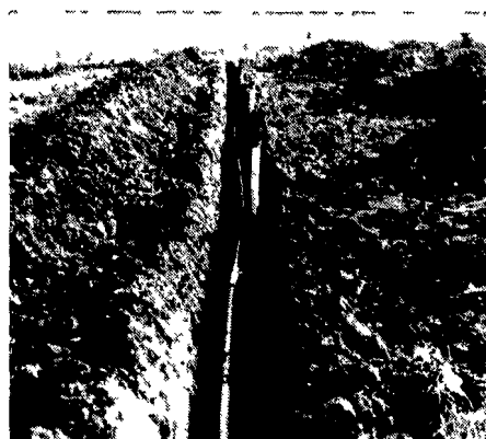
Tubazioni corrugate di Sicron/Vipla o di Moplen-Ro. Vengono interrati nelle zone ove si verificano prolungati ristagni d'acqua. Sono il mezzo più rapido per raccogliere e convogliare all'esterno l'acqua in eccesso.
