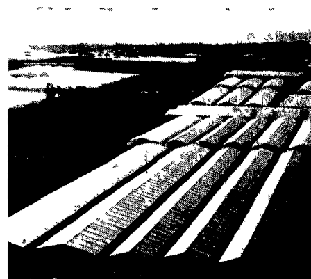
Panoramica di serre fisse nella zona di Fondi (Latina). Si può scegliere fra: lastre ondulate di Ignilux, lastre nervate di Polionda, film di Plypac, film di Fertene/Celene. Rispetto al vetro, la plastica è più resistente, maneggevole ed assorbe meglio il calore.
