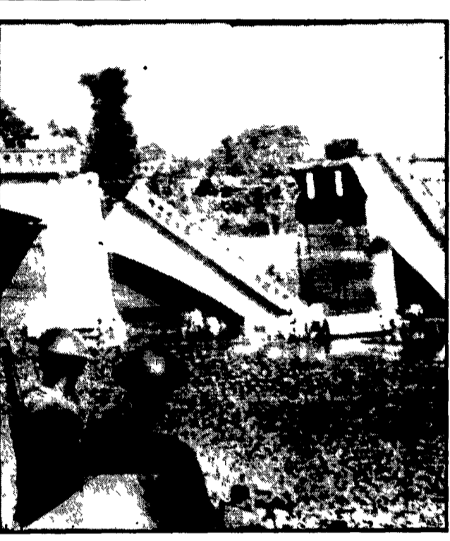
Un ponte nei pressi di Jessoro distrutto dalle truppe pakistane in ritirata
