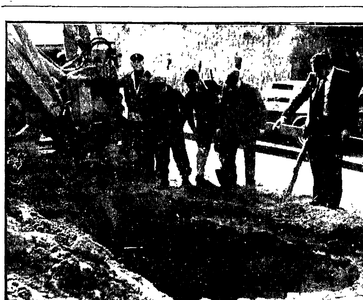
NAPOLI: PERICOLO DI SMOTTAMENTO A Napoli, in via Mascagni, che è il prolungamento di via Riberia, la sera del 29 novembre scorso si verificò una improvvisa voragine. Era una scava senza, ci si è accorti che era una cosa seria. Ci si è trovati di fronte, cioè, ad un terrapieno profondo una quindicina di metri e completamente inibito « per mesi, un « fognolo » privato aveva perduto acqua, lasciando defluire nel sottosuolo. Per fortuna, il segno premonitore del 29 novembre è stato giustamente interpretato da alcuni vigili urbani: altrimenti si sarebbe avvertito il pericolo in ampie proporzioni e dalle conseguenze assai gravi. NELLA FOTO: la voragine in via Mascagni a Napoli.
