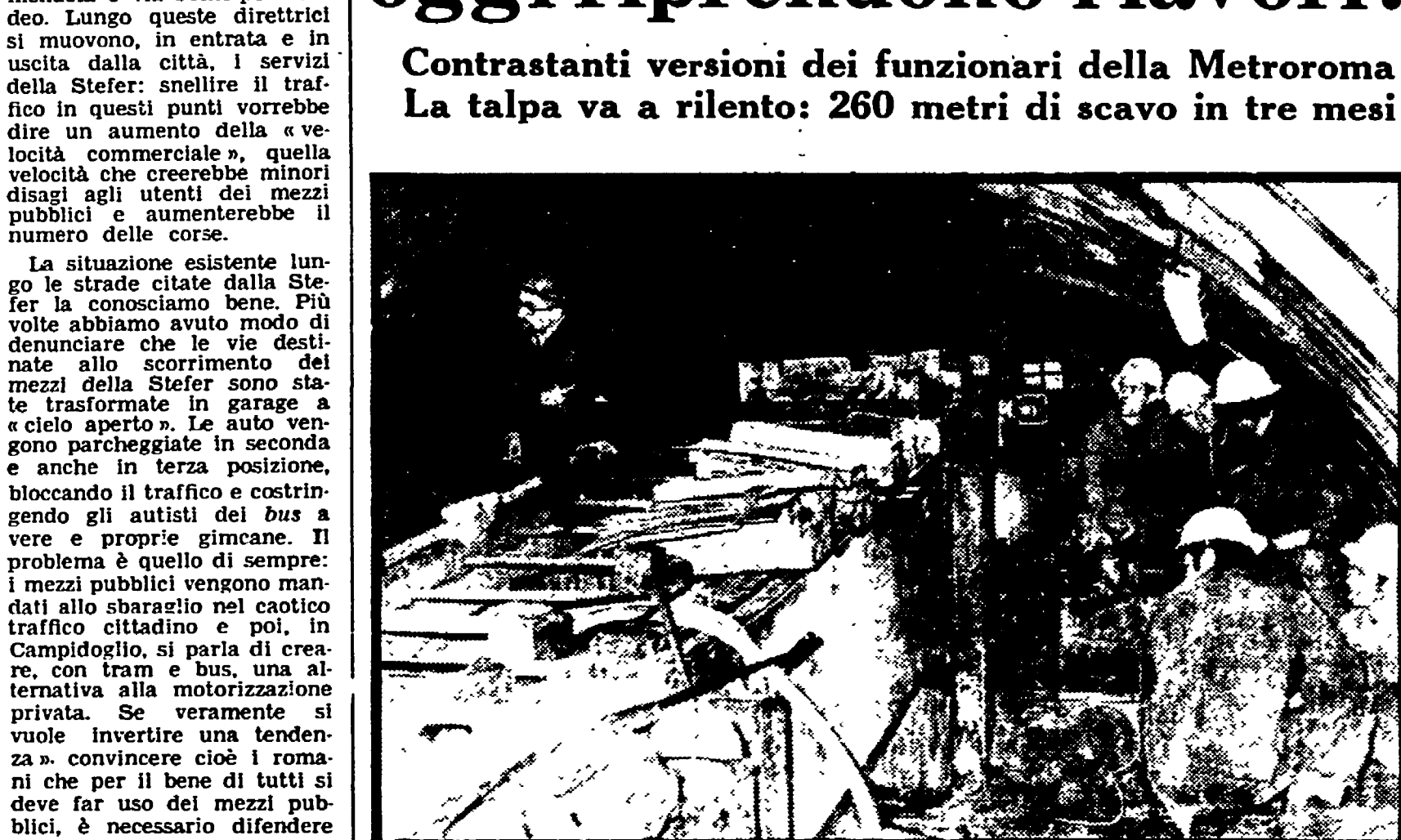
Il cantiere del metrò dove si è sviluppato l'incendio l'altro ieri
