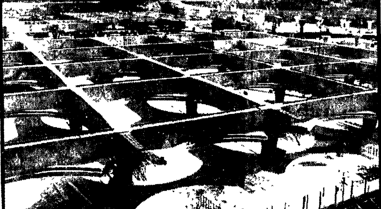
Fra cinque mesi sarà pronto il grande parcheggio sotterraneo di Villa Borghese. Questa almeno è l'opinione dell'ing. Renzo Rosi, direttore della società costruttrice. La posa delle cupole prefabbricate che ricoprono la vasta area del parcheggio (la cui capacità è di duemila posti) è quasi terminata, mentre a buon punto sono gli impianti di illuminazione.
