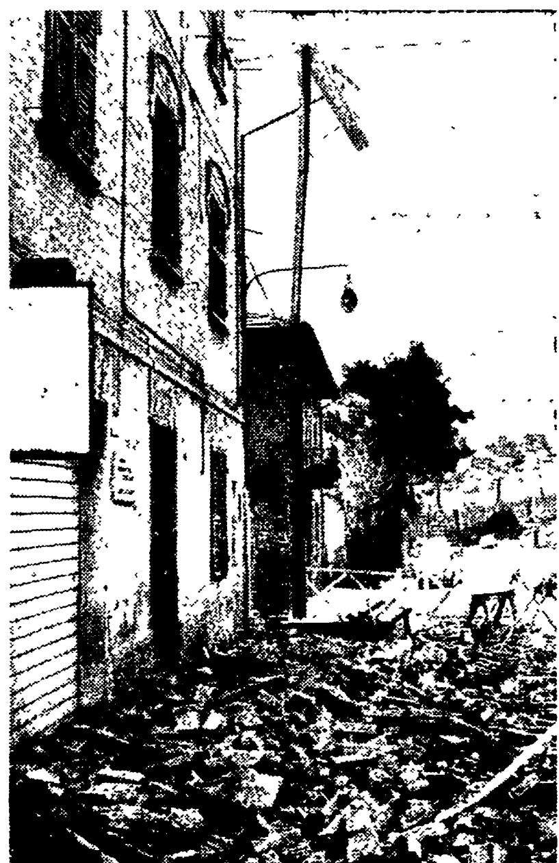
ANCONA — Un aspetto delle distruzioni arrecate dal terremoto. Molte di queste case dovranno essere abbattute perché pericolanti.
