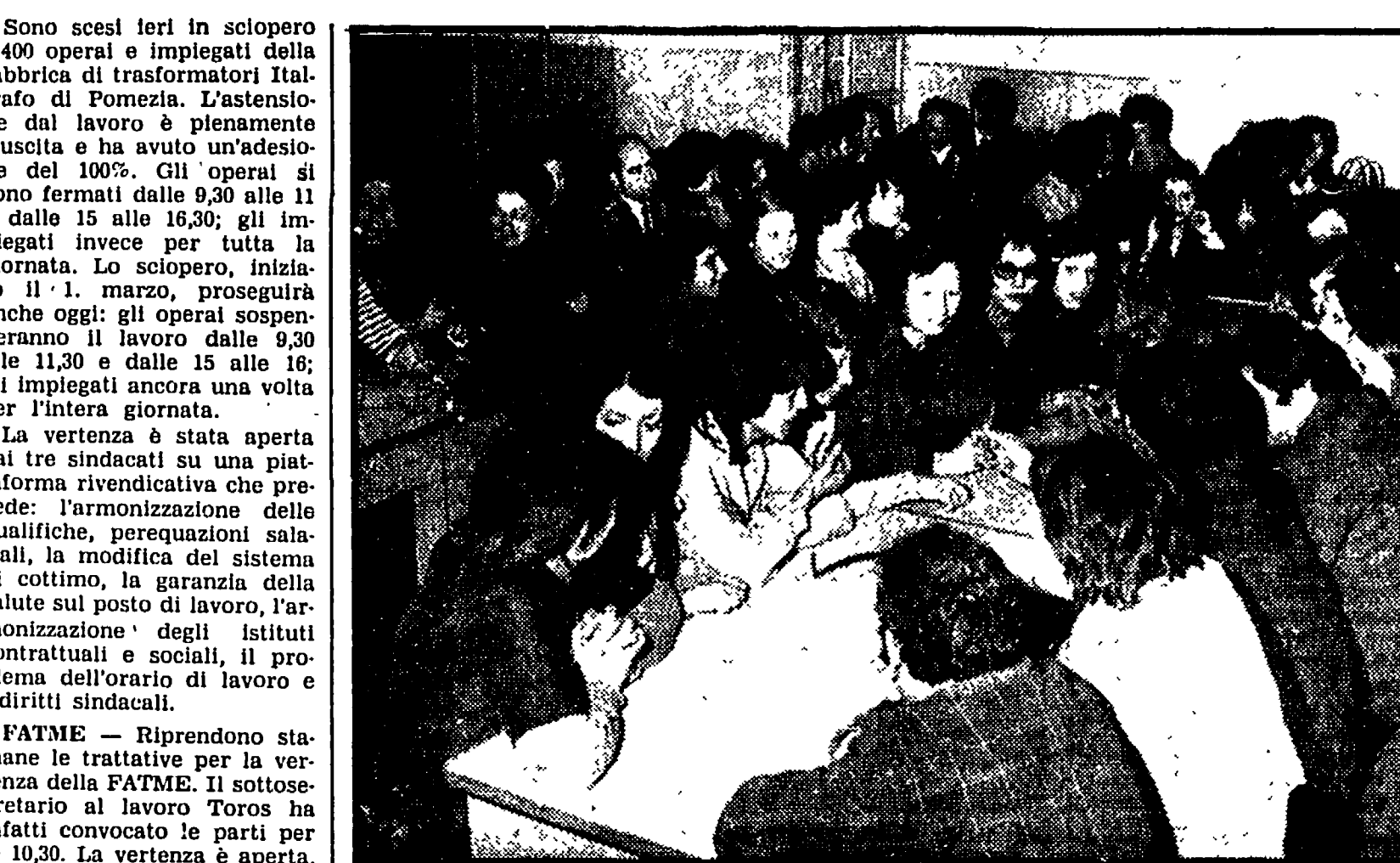
Sono scesi ieri in sciopero 400 operai e impiegati della fabbrica di trasformatori Italtrafo di Pomezia. L'astenimento dal lavoro è pienamente riuscito e ha avuto un'adesione del 100%...
