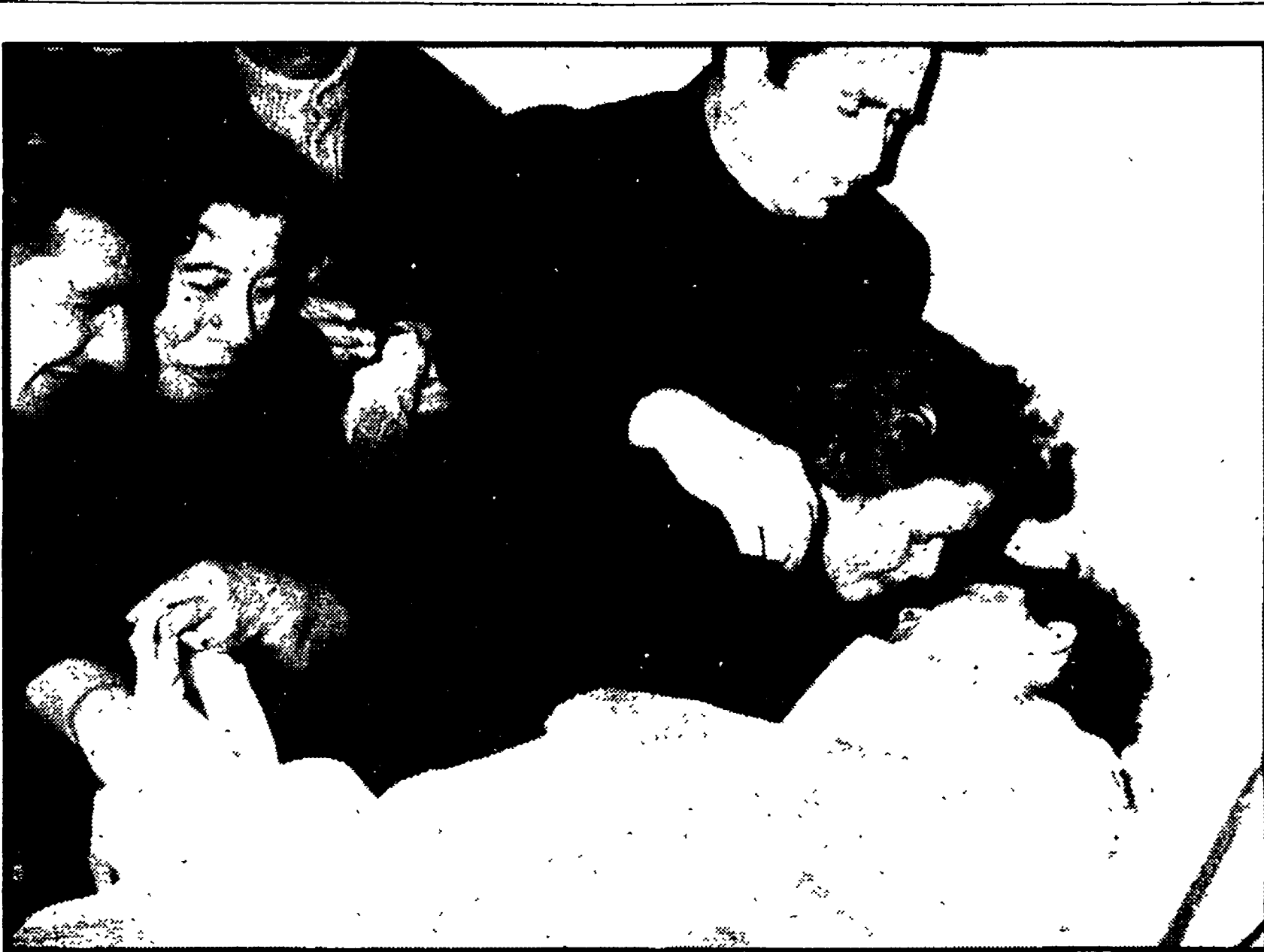
PALERMO - La madre di Domenico Verisco abbraccia disperata la salma del figlio morto folgorato in un cantiere edile
