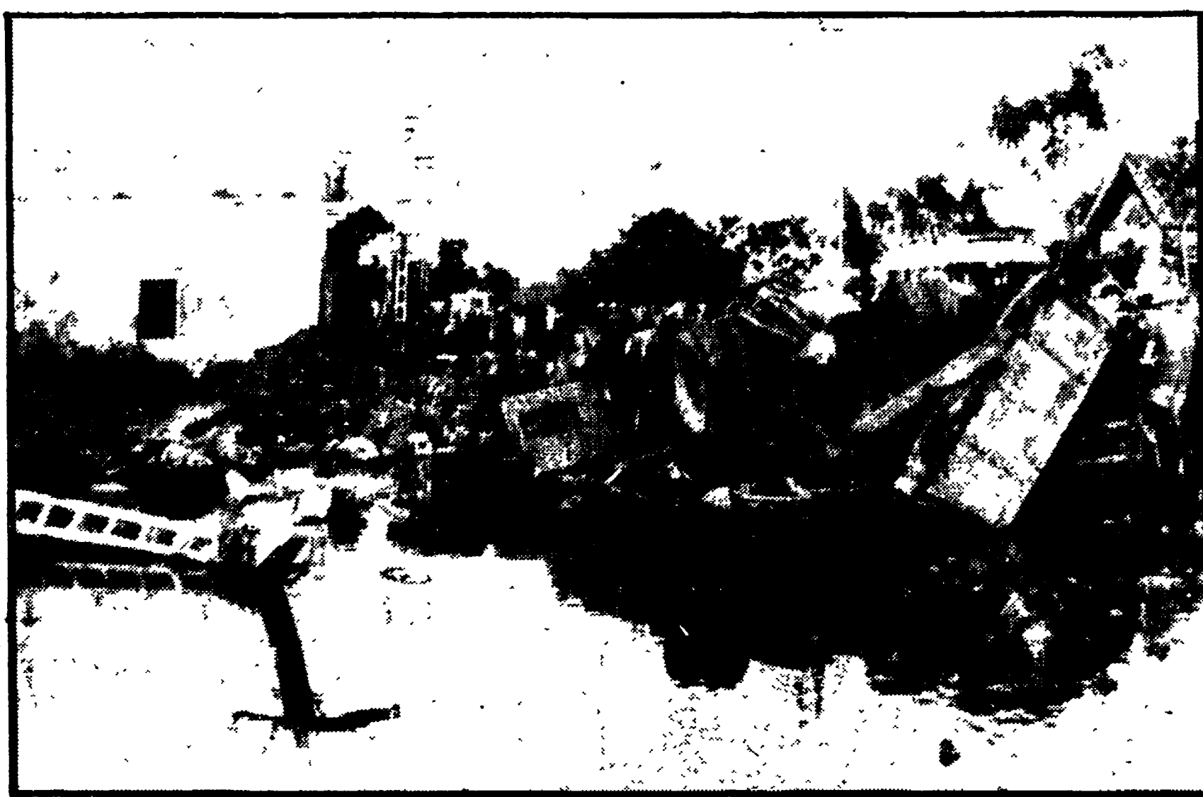
Immagine delle distruzioni provocate nel quartiere centrale di An Duong, ad Haiphong, dai criminali bombardamenti aerei americani dei giorni scorsi. La foto — diffusa dall'agenzia di stampa della RDV — mostra le rovine della zona del mercato di Haiphong, situata nel suddetto quartiere
