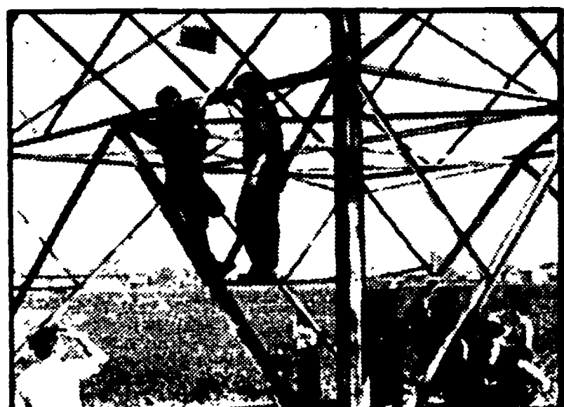
I lavori di ripristino del traliccio di Segrate pochi giorni dopo il rinvenimento del cadavere di Feltrinelli
