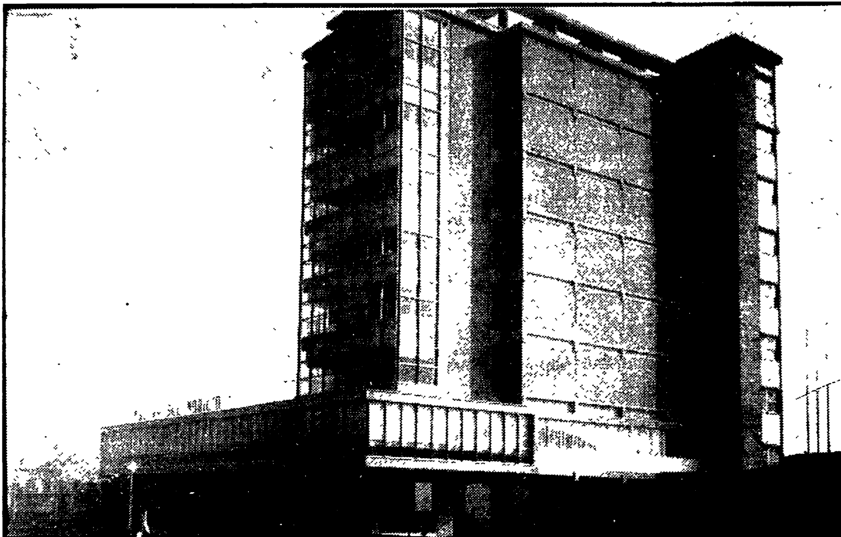
PONSACCO (Pisa) — Il palazzo della Mostra Permanente del Mobiliario, costruito da una cooperativa formata da oltre 100 artigiani. Per la realizzazione dell'opera — costata oltre 150 milioni — il governo non ha dato alcun contributo.
