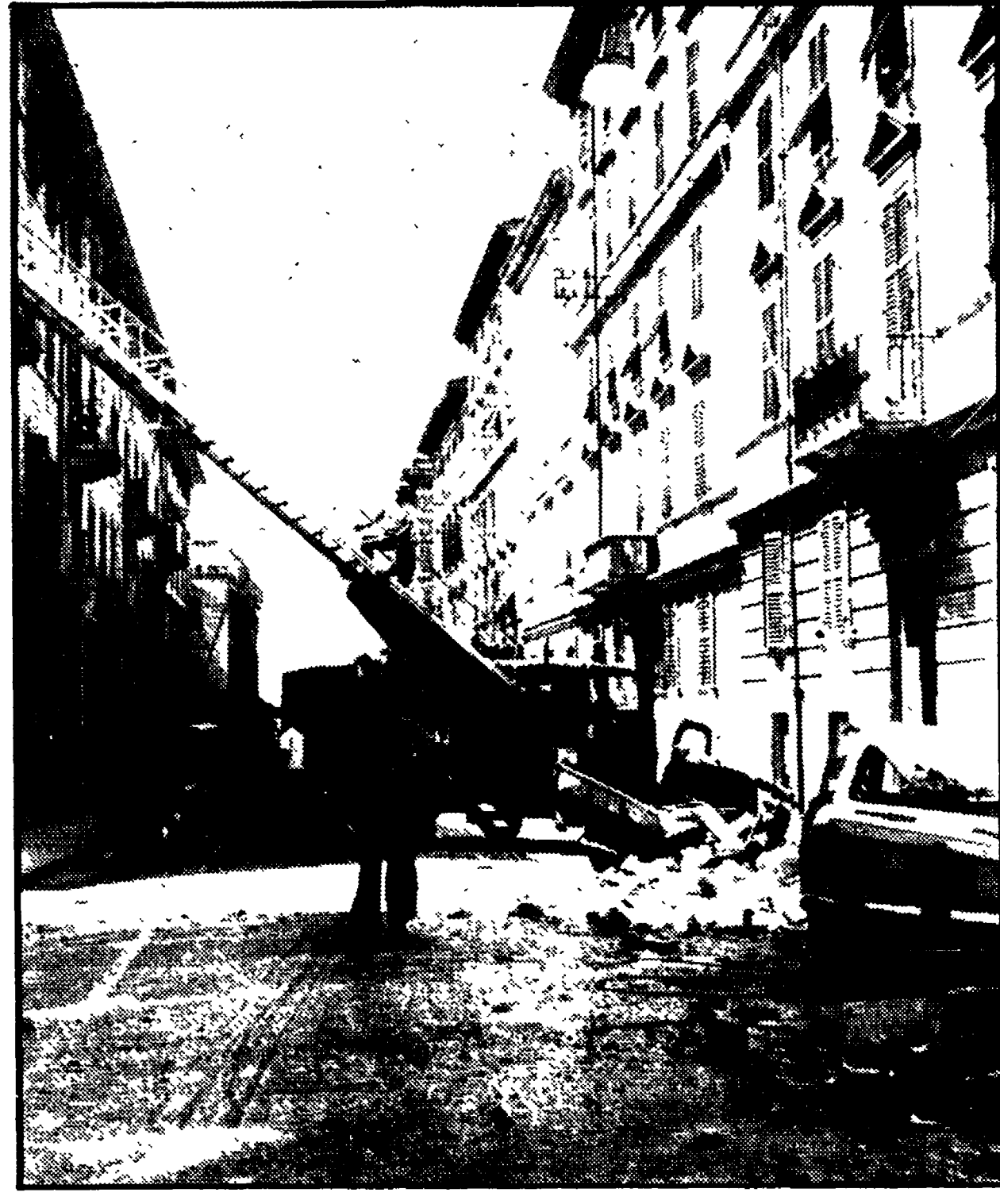
ANCONA — Un'immagine del centro della città: è perfino pericoloso transitare in queste strade
