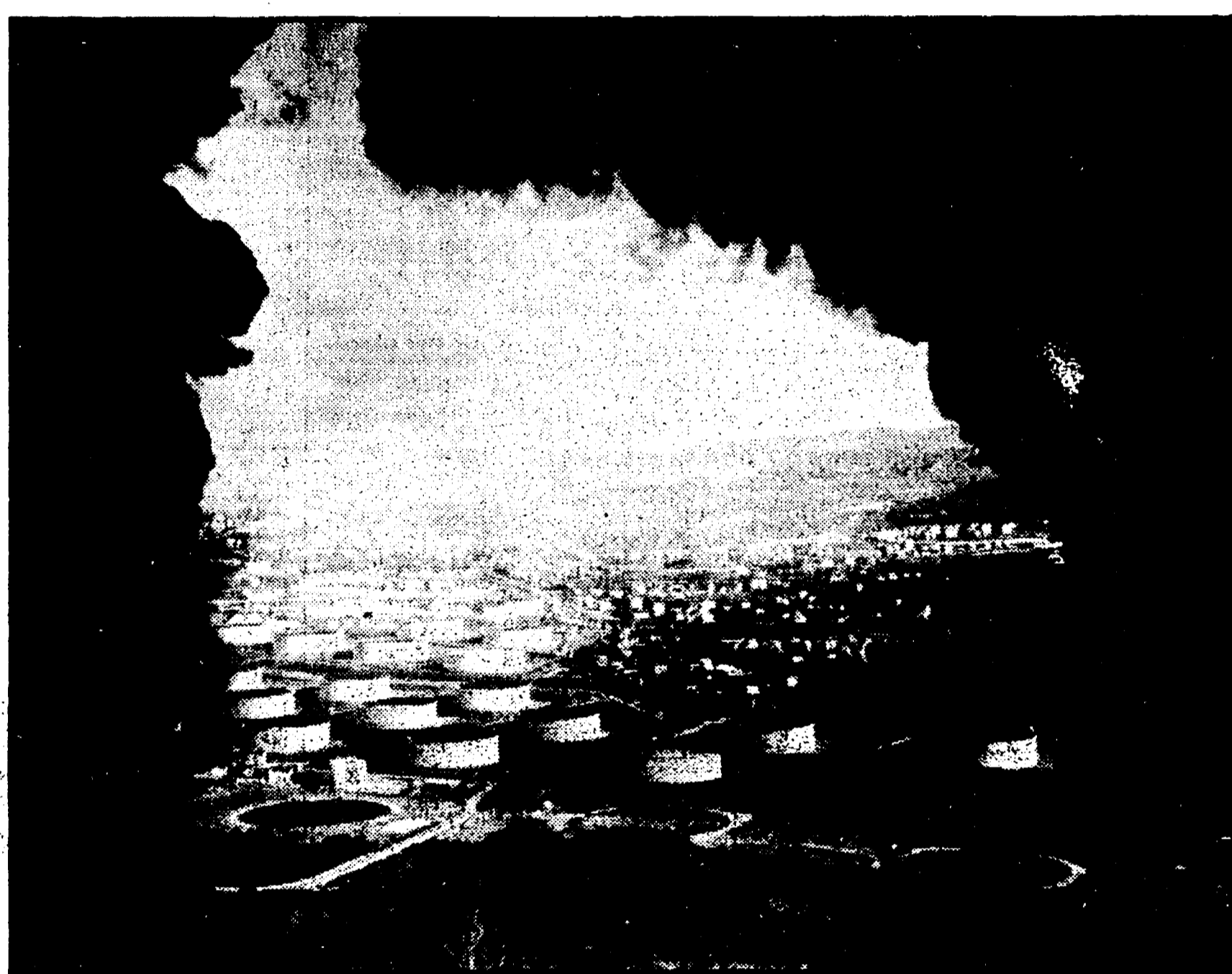
TRIESTE — Densissime colonne di fumo si levano dai serbatoi dell'oleodotto dopo l'esplosione
