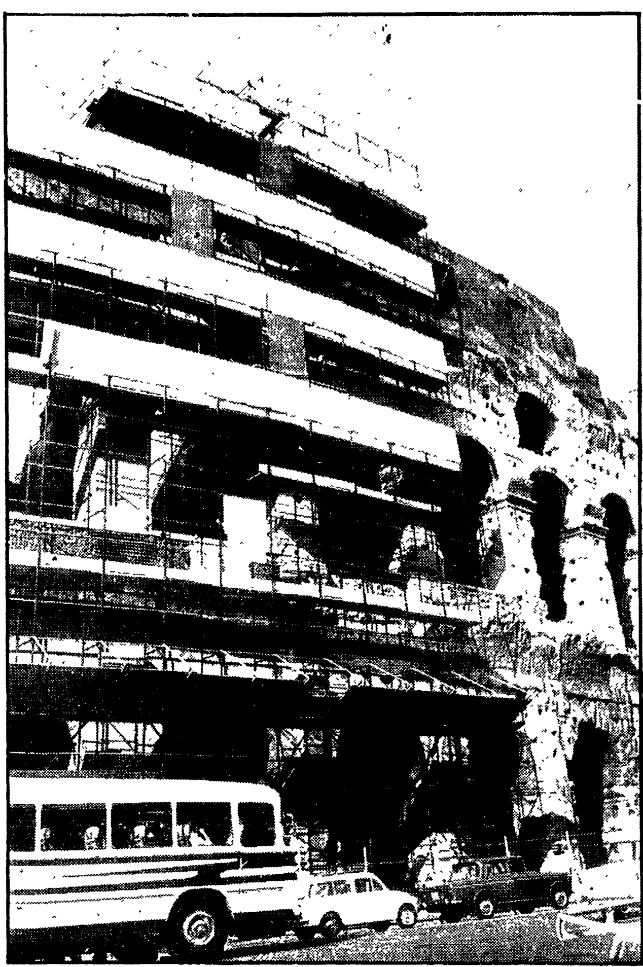
Ecco come appare in questi giorni il Colosseo dopo i lavori di restauro ordinati dalla sovrintendenza ai monumenti. Due semicerchi sono stati « ingabbiati »
