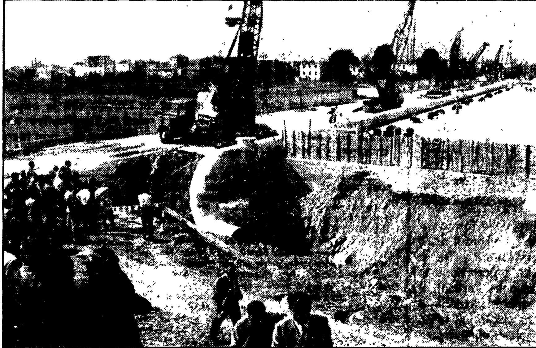
ACQUA PER MEZZO SECOLO BOLOGNA - Ci sono volute sei potenti autogre per sollevare questo enorme tubo lungo 150 metri, largo un metro...
