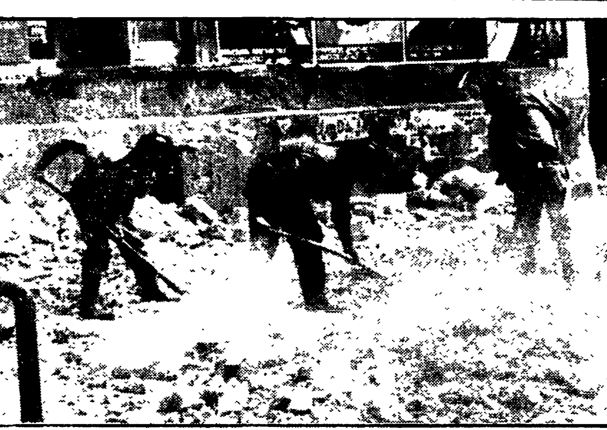
NAPOLI - Il cornicione di un vecchio fabbricato in via Resina 232, ad Ercolano è crollato improvvisamente ieri mattina abbattendosi sul marciapiede. Una donna che si trovava alla fermata dei pullman di linea in attesa della corriera per Napoli, è stata investita in pieno dalla massa di pietre e calcinacci. La donna, identificata per Cira Perna, di 60 anni, moglie di un operaio e madre di tre figli, è morta poco dopo. Nella foto: i vigili del fuoco sgomberano i detriti del cornicione crollato
