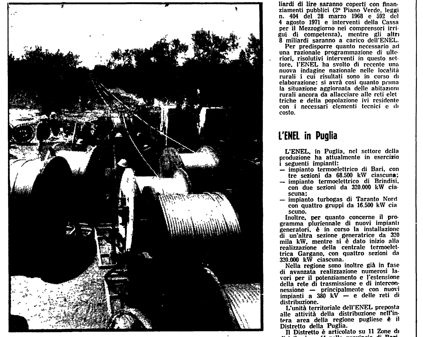
La messa in opera dell'elettrodotto 380 Kv Foggia-Taranto.
