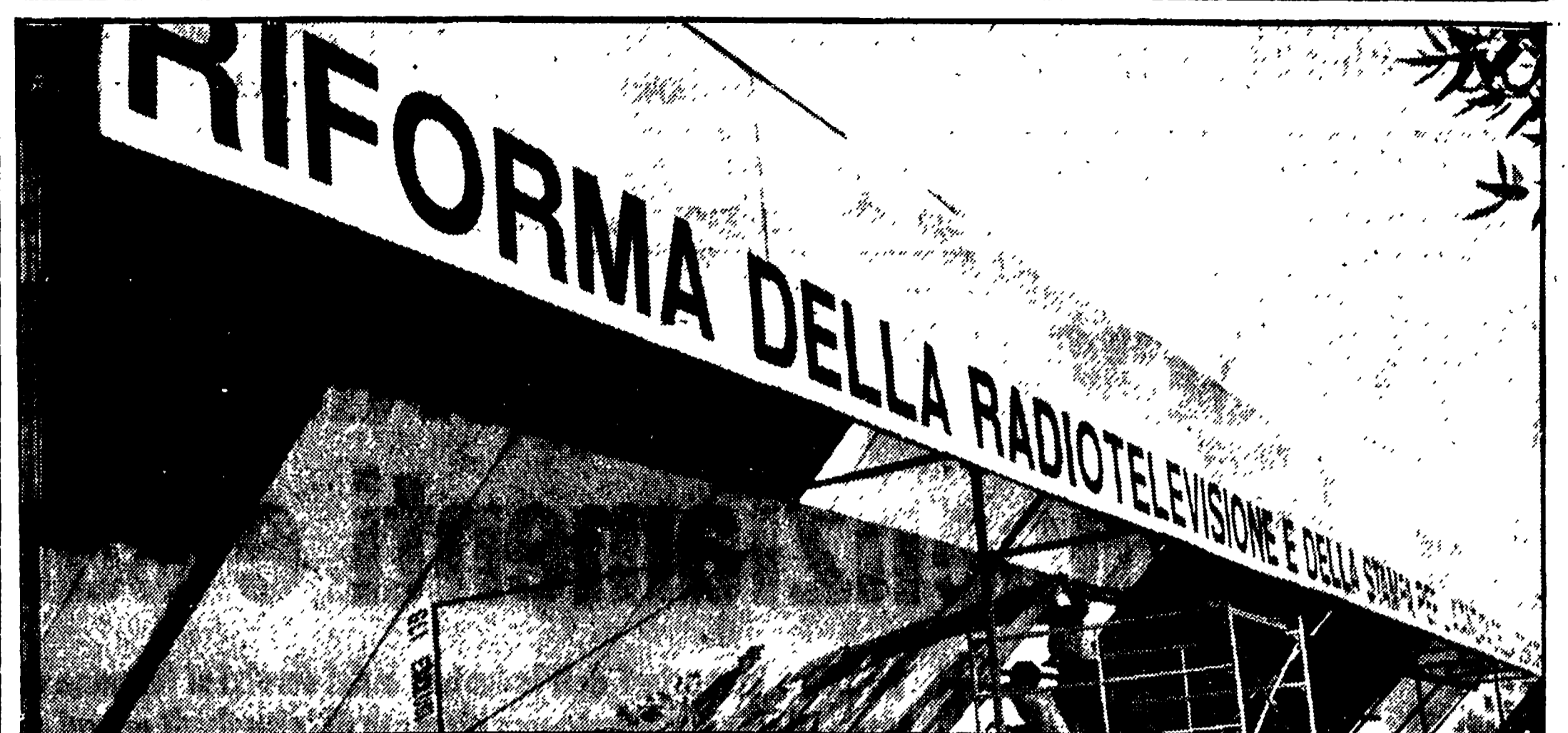
Il padiglione dedicato alla televisione e alla informazione in costruzione al villaggio Olimpico
