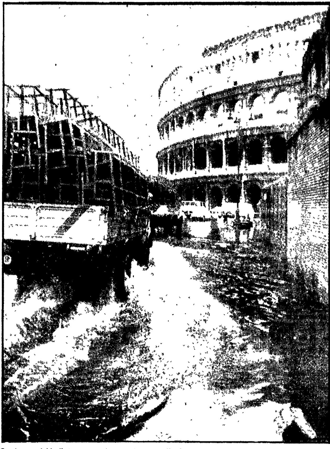
Camion carichi di transenne in marcia verso l'anfiteatro da puntellare
