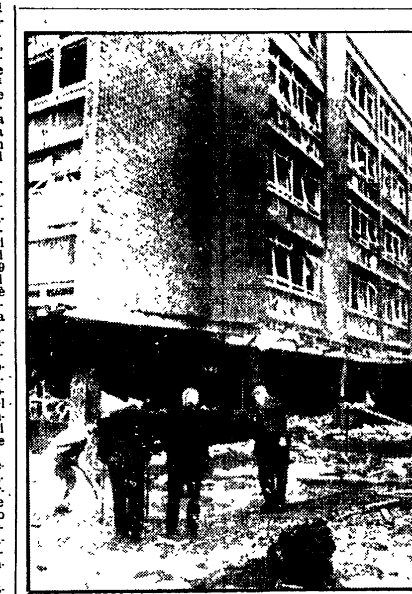
ATTENTATI NELL'IRLANDA DEL NORD Continua nell'Ulster la catena delle esplosioni terroristiche. A Belfast, un'auto-bomba è saltata in aria in Victoria street danneggiando gravemente (come mostra la foto) un edificio adibito ad uffici, privati e governativi; a Londonderry, un camion imbottito con quasi tre quintali di esplosivo è stato lanciato contro una stazione di polizia. In entrambi i casi non si lamentano vittime umane; solo in Victoria street si sono avuti quattro feriti leggeri
